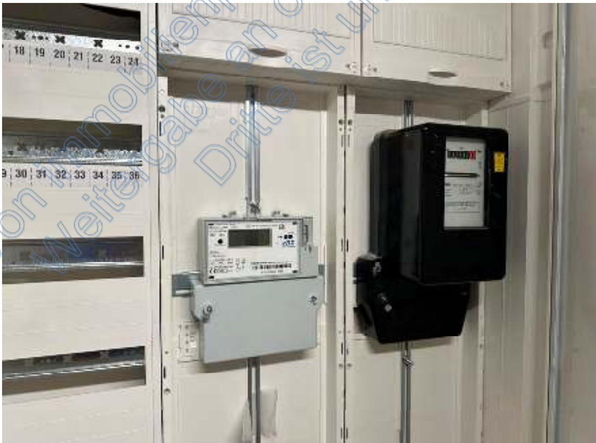
Bild 28: Ausschnitt – Stromzähler im Zählerkasten im Hausanschluss- & Heizungskellerraum
