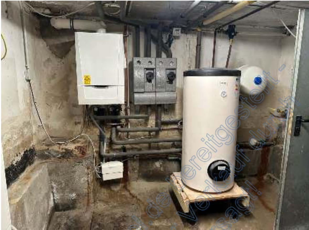
Bild 27: Ausschnitt – gemeinschaftliche Heizungsanlage im Hausanschluss- & Heizungskellerraum (Wohnhaus mit zwei Eigentumswohnungen KG).
