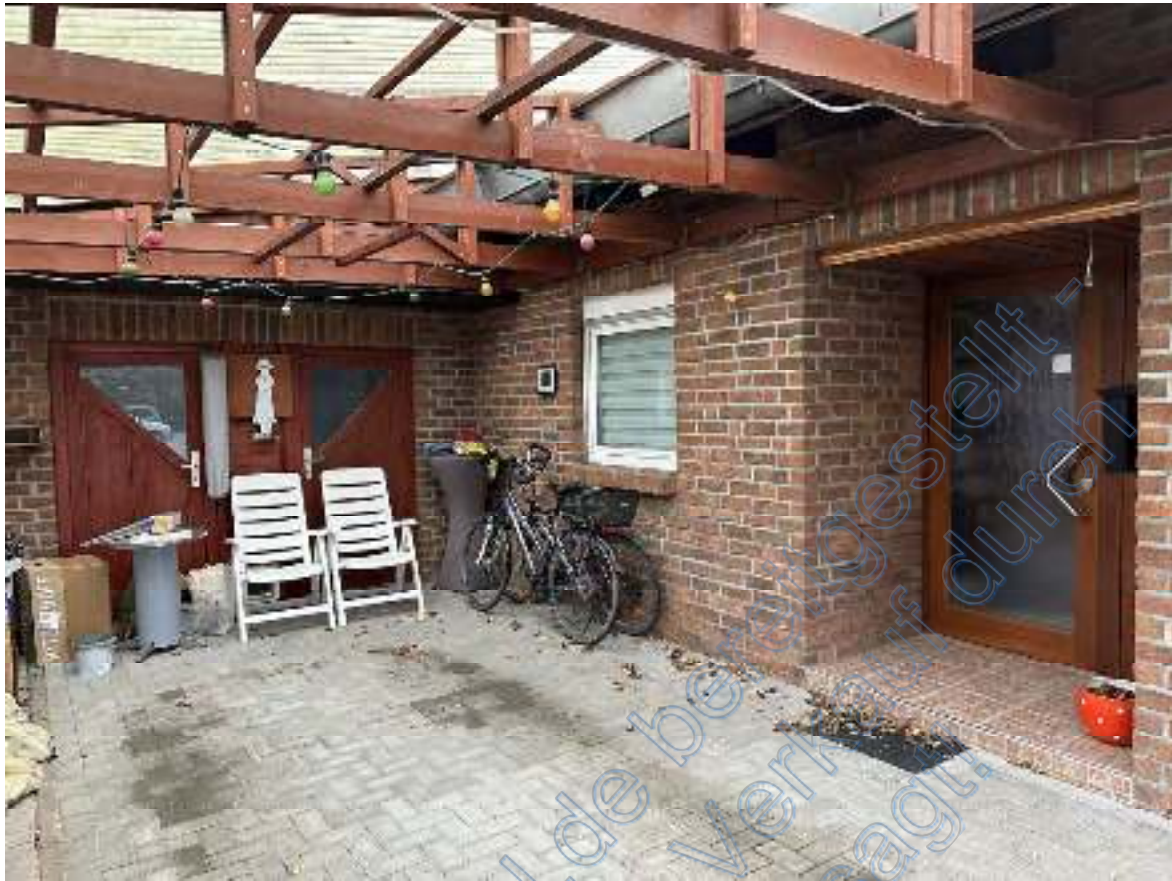
Bild 05: Blick aus dem Carport auf die geschlossene Hauseingangstür zum Windfang des Wohnhauses . Links sind die geschlossenen Türen zur ehemaligen Garage / zum jetzigen Geräteraum zu sehen.
