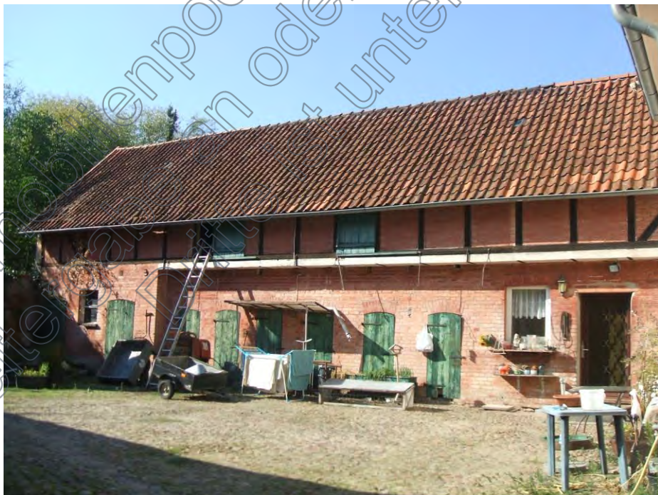
Foto 4: Nebengebäude (B), Ostansicht aufgenommen am 30.09.2022
