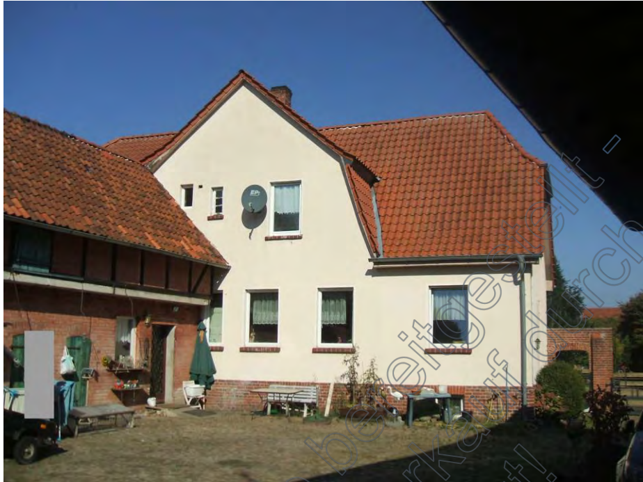
Foto 3: Wohnhaus (A) mit Nebengebäude (B), Südostansicht aufgenommen am 30.09.2022
