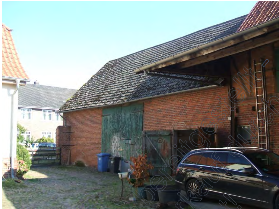
Foto 5: Scheune/ Stall (C), Nordteil, Südwestansicht aufgenommen am 30.09.2022
