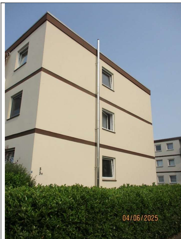
Ansicht von Osten
