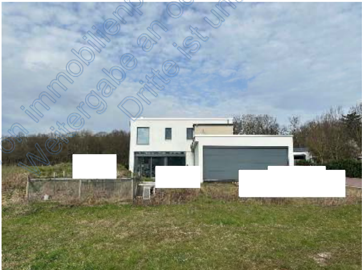
Bild 04: Blick von der südlichen Grundstücksgrenze des Bewertungsflurstücks 19/17 auf die eingeschossige Südseite (mit geschlossenem Rolltor zur Garage) und die zweigeschossige Südseite des Einfamilienhauses.
