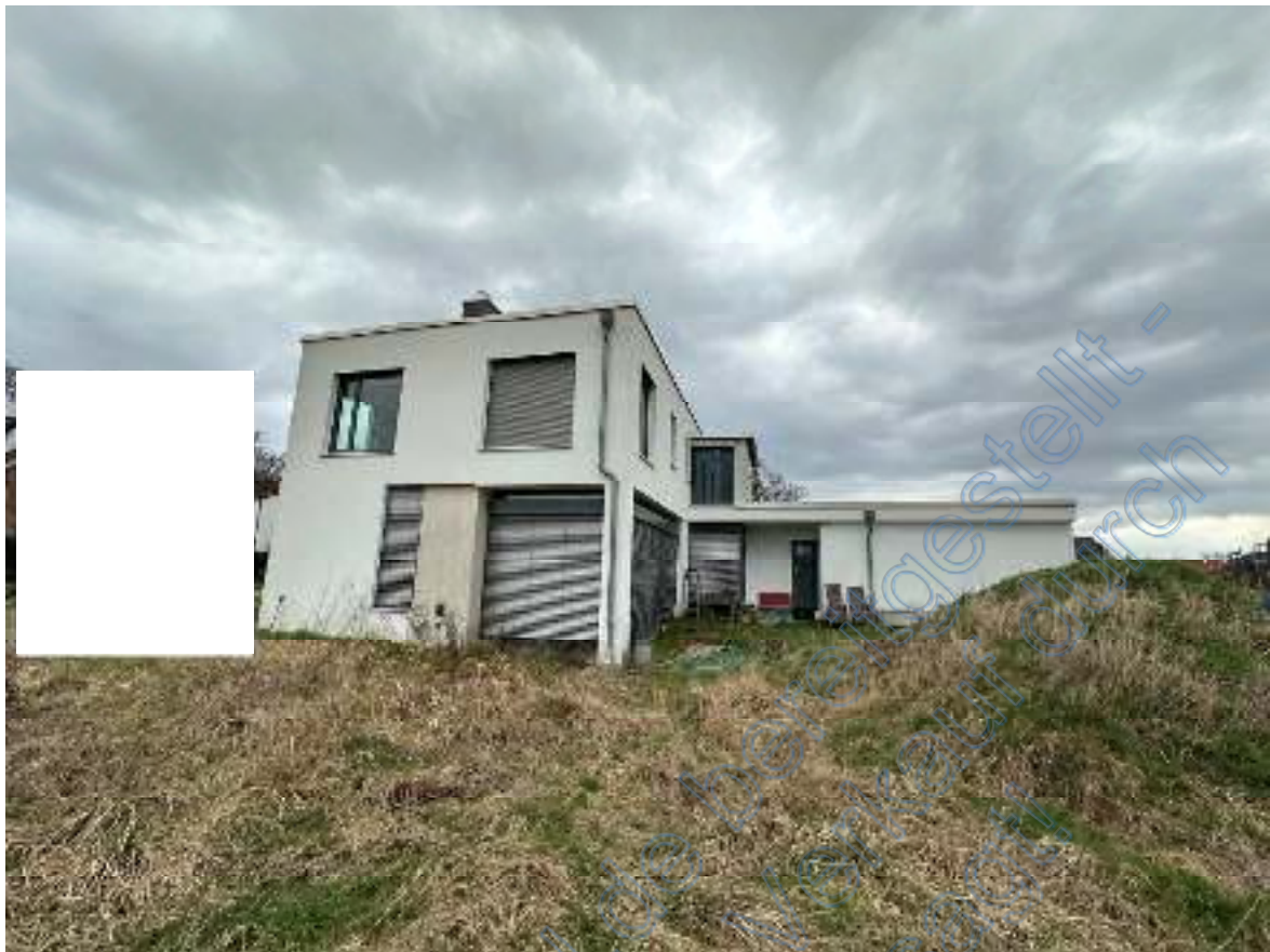
Bild 07: Blick von der westlichen Grundstücksgrenze des Bewertungsflurstücks 19/17 auf die zweigeschossige West- und Südseite sowie die eingeschossige Westseite des Einfamilienhauses .
