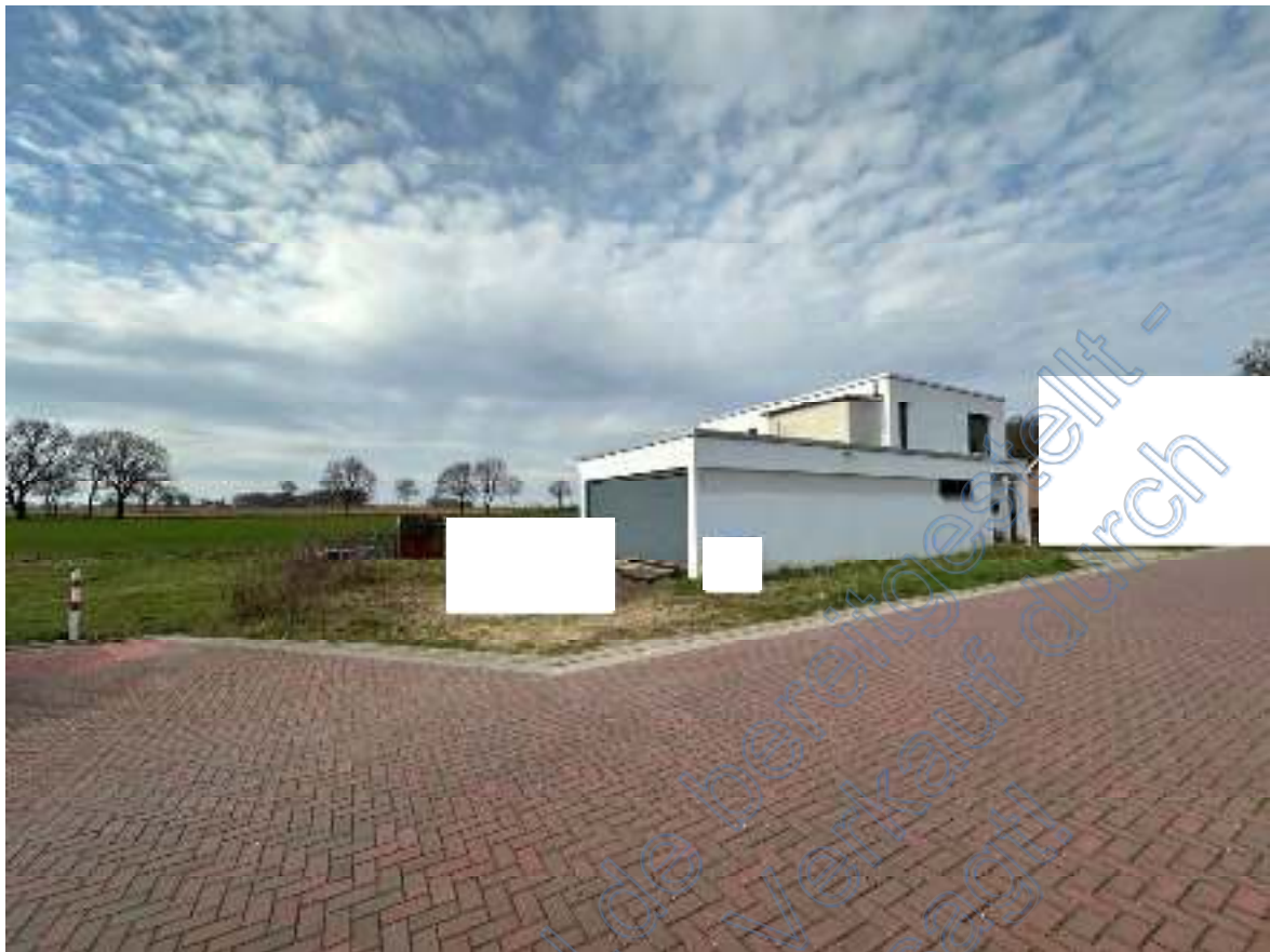
Bild 03: Blick von der Beekenriede auf die Ostseite und die sich links anschließende Südseite (mit geschlossenem Rolltor zur Garage) des eingeschossigen Teilbereiches des Einfamilienhauses .
