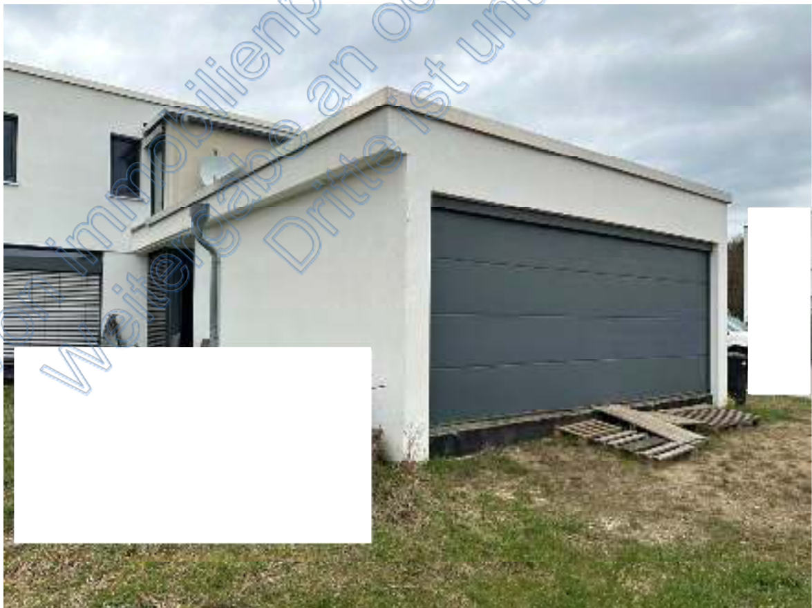
Bild 06: Blick auf die West- und die Südseite des eingeschossigen Teilbereiches des Einfamilienhauses . Aufgrund der fehlenden Höhe („Aufschüttung“ oder Pflasterung) ist die eigentliche Nutzung der Garage z. Zt.
