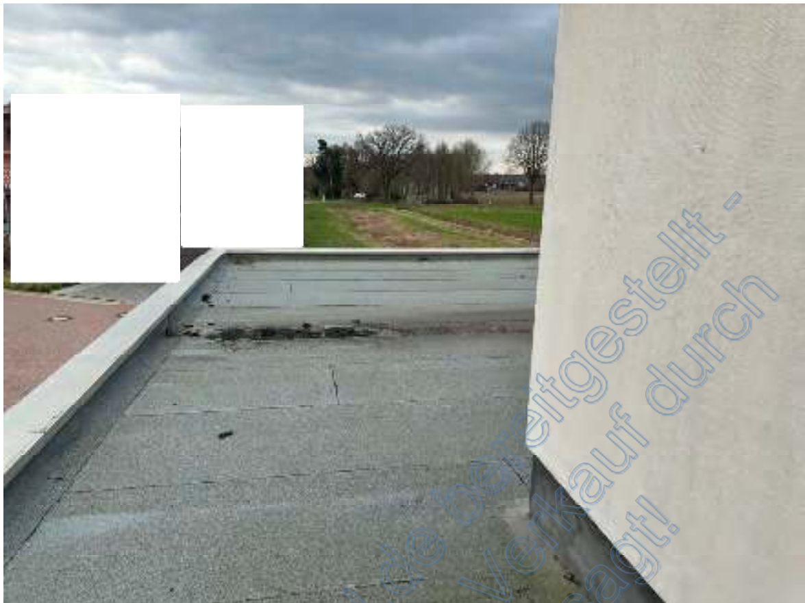
Bild 24: Blick über die Dachfläche des eingeschossigen Teilbereiches des Einfamilienhauses in Richtung Süden.
