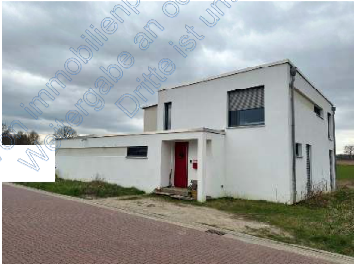
Bild 02: Blick von der Beekenriede auf die ein- & zweigeschossige Ostseite (Eingangsseite) und die sich rechts anschließende Nordseite des Einfamilienhauses . Im Wärmedämmputz sind in beiden
