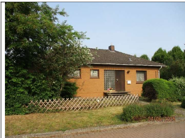
Straßenseite „Zur Alten Mühle“
