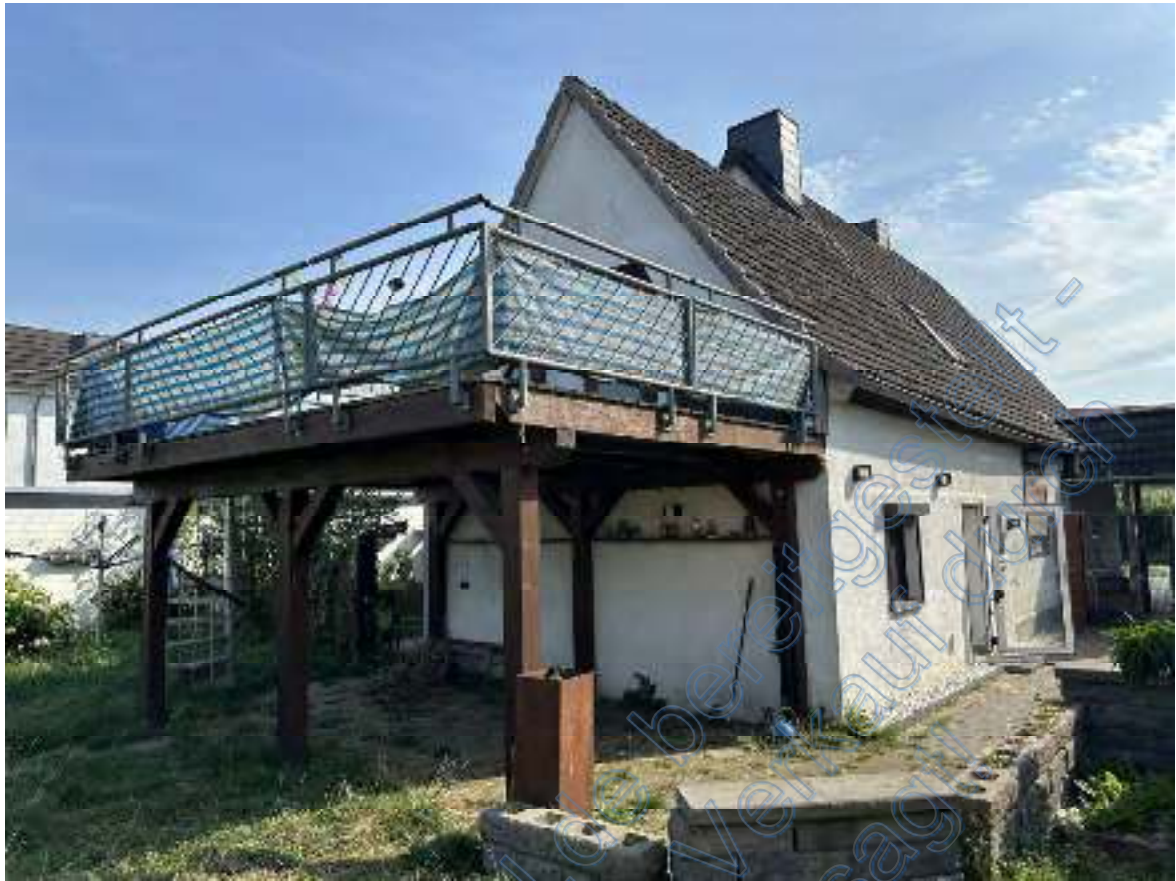
Bild 07: Blick auf den Balkonvorbau an der nördlichen Giebelseite des Wohnhausanbaus. Rechts ist die westliche Traufseite des Wohnhausanbaus zu sehen.
