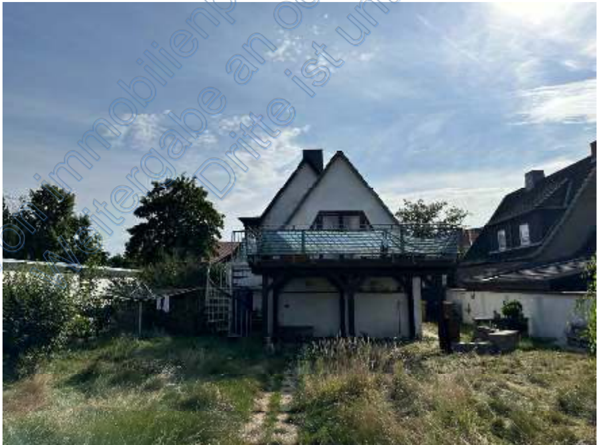
Bild 08: Blick von der rückwärtigen Grundstücks- bzw. Gartenfläche über den Balkonvorbau auf die nördliche Giebelseite des Wohnhausanbaus. Links dahinter ist ein Teil des Wohnhauses zu sehen.
