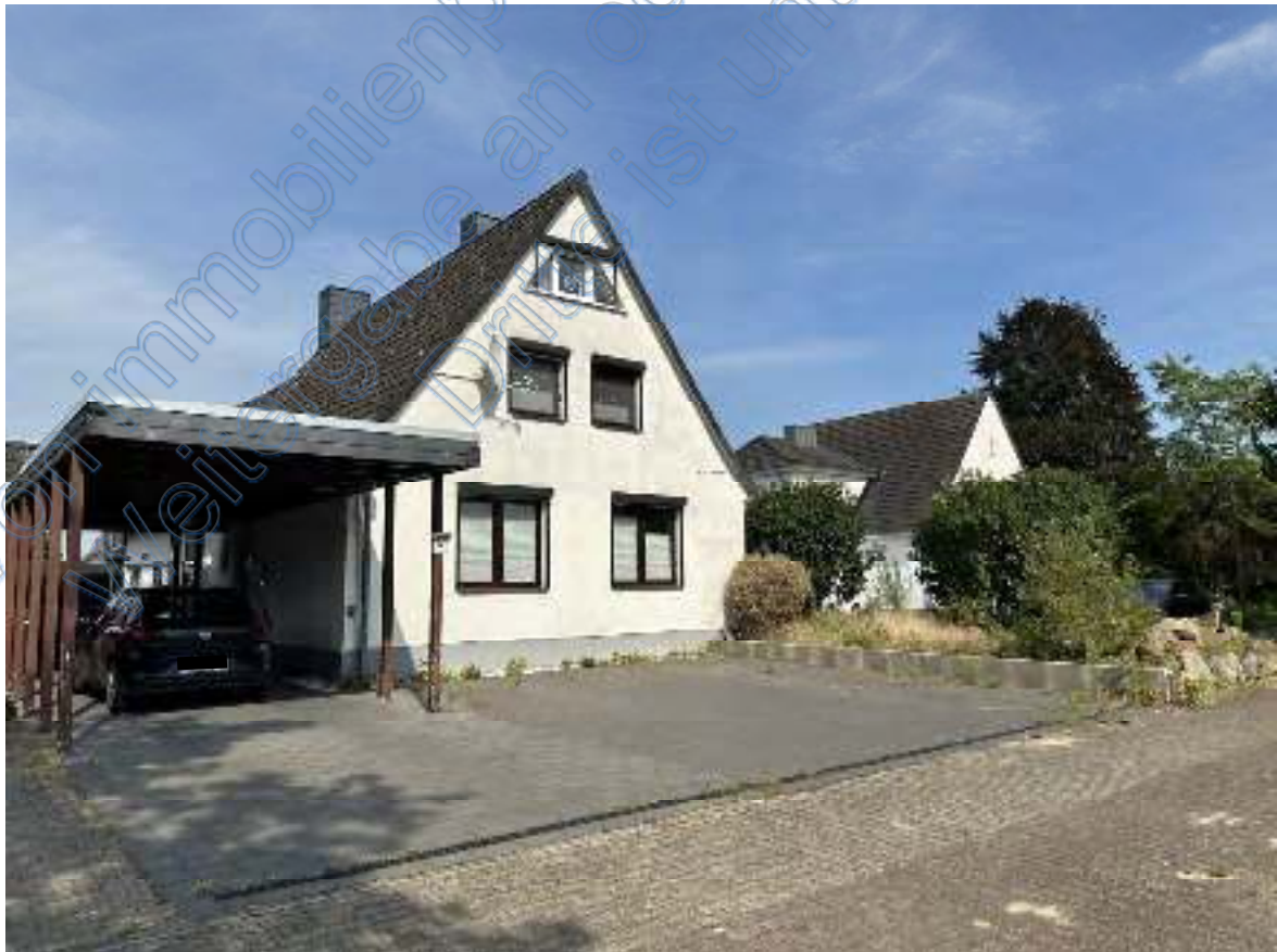
Bild 04: Blick über die Südwestecke des Bewertungsflurstücks 82/1 (links unten) auf die südliche Giebelseite des Wohnhauses des Bewertungsobjektes sowie auf und in den sich links anschließenden Carport.
