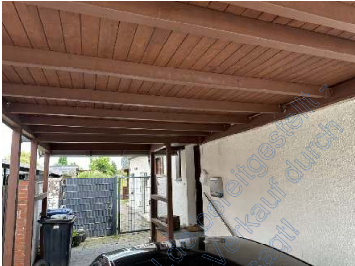
Bild 05: Blick durch den Carport sowie auf und entlang der westlichen Traufseite des Wohnhauses (und durch das geschlossene Zugangstor) in Richtung der westlichen Traufseite des Wohnhausanbaus. Mitte rechts ist die Hauseingangstür zu sehen.
