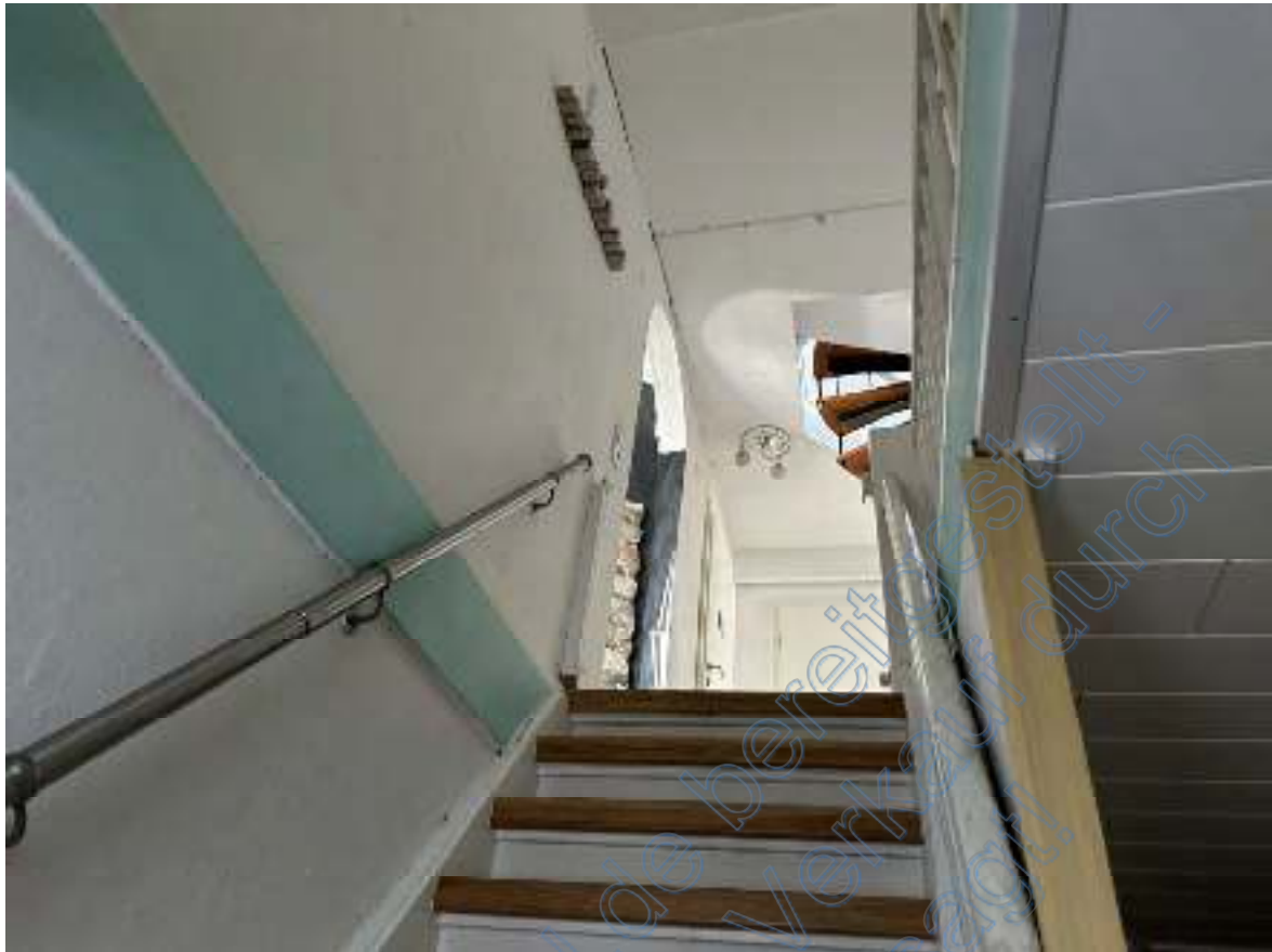
Bild 17: Ausschnitt – Treppe Richtung Flur im Dachgeschoss (Wohnhaus EG Richtung DG).
