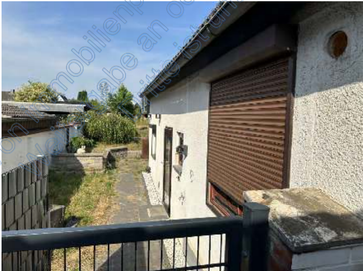
Bild 06: Blick (über das geschlossene Zugangstor) und entlang der westlichen Traufseite des Wohnhausanbaus in Richtung der nördlichen Grundstücks- bzw. Gartenfläche.
