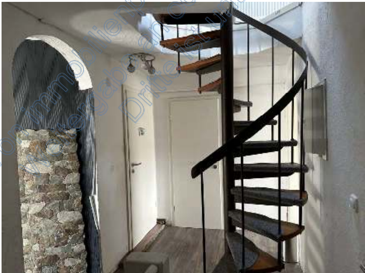
Bild 18: Ausschnitt – Flur mit Wendeltreppe zum Spitzbodenraum im Spitzbodengeschoss (Wohnhaus DG).
