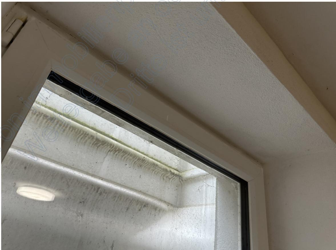
Bild 32: Ausschnitt – Feuchtigkeitsdurchdringungen im Sturzbereich
