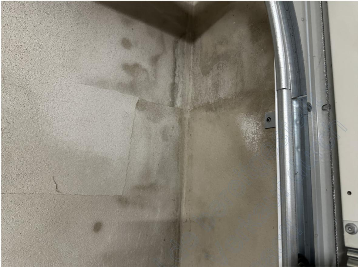
Bild 37: Ausschnitt – Feuchtigkeitsdurchdringungen in der Südwestecke der Doppelgarage (Doppelgarage EG).
