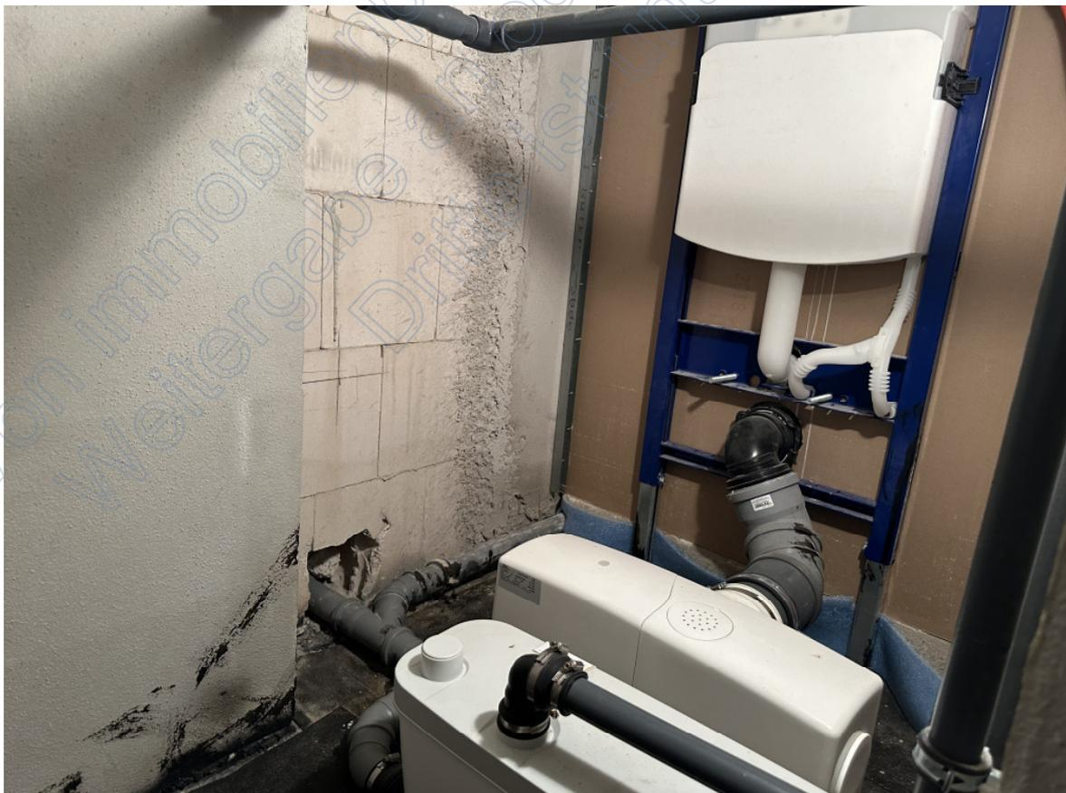
Bild 28: Ausschnitt – Spülkasten und Hebeanlage des WC „unter der Treppe“
