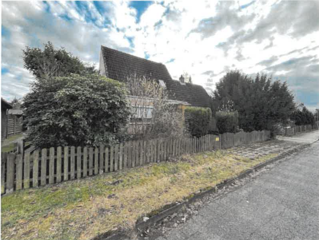
Bild 3 - Außenansicht, Ansicht Straßenseite, Vorgarten, Holzzaun
