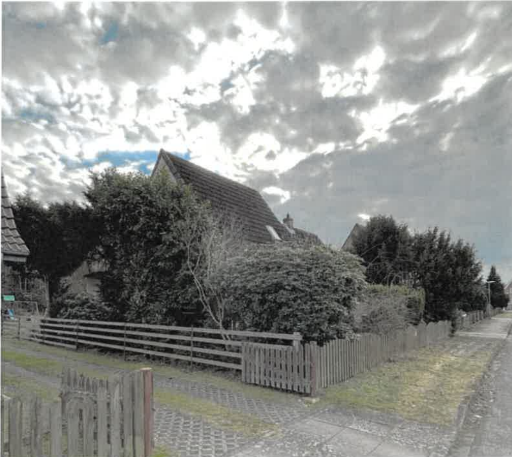
Bild 2 - Seitenansicht, Straßenzug, Holzzaun, Heckenbewuchs
