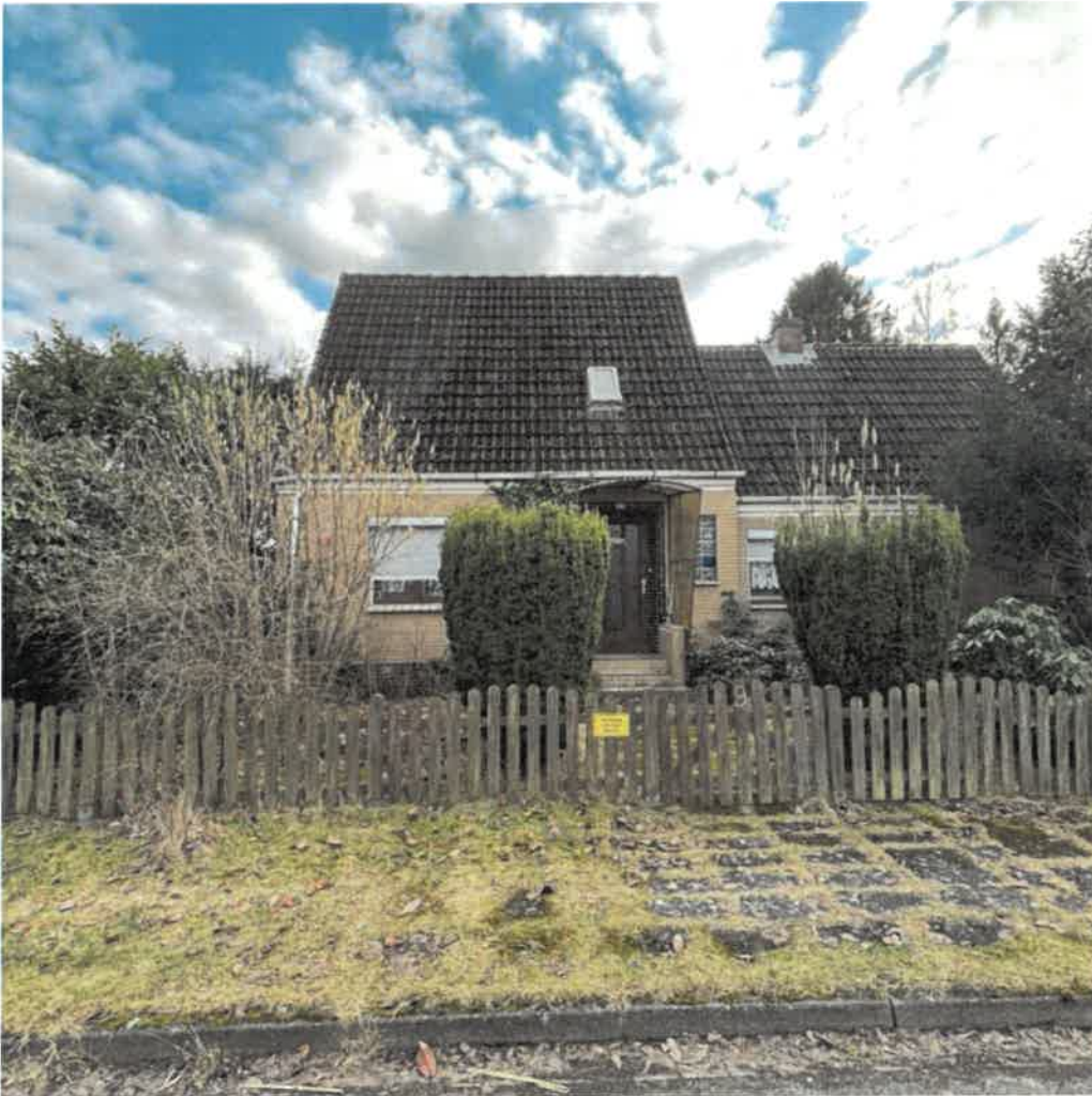
Bild 1 - Außenansicht, Ansicht Straßenseite, Vorgarten, Holzzaun, Satteldach
