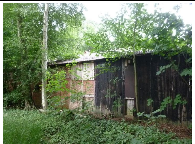
Ansicht Remise vom Feldweg
