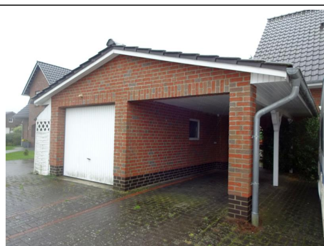
Ansicht von der Straße / von Nordwesten
