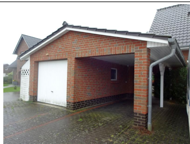
Ansicht von der Straße / von Nordwesten
