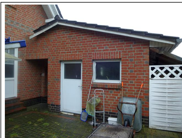
Ansicht von Südosten
