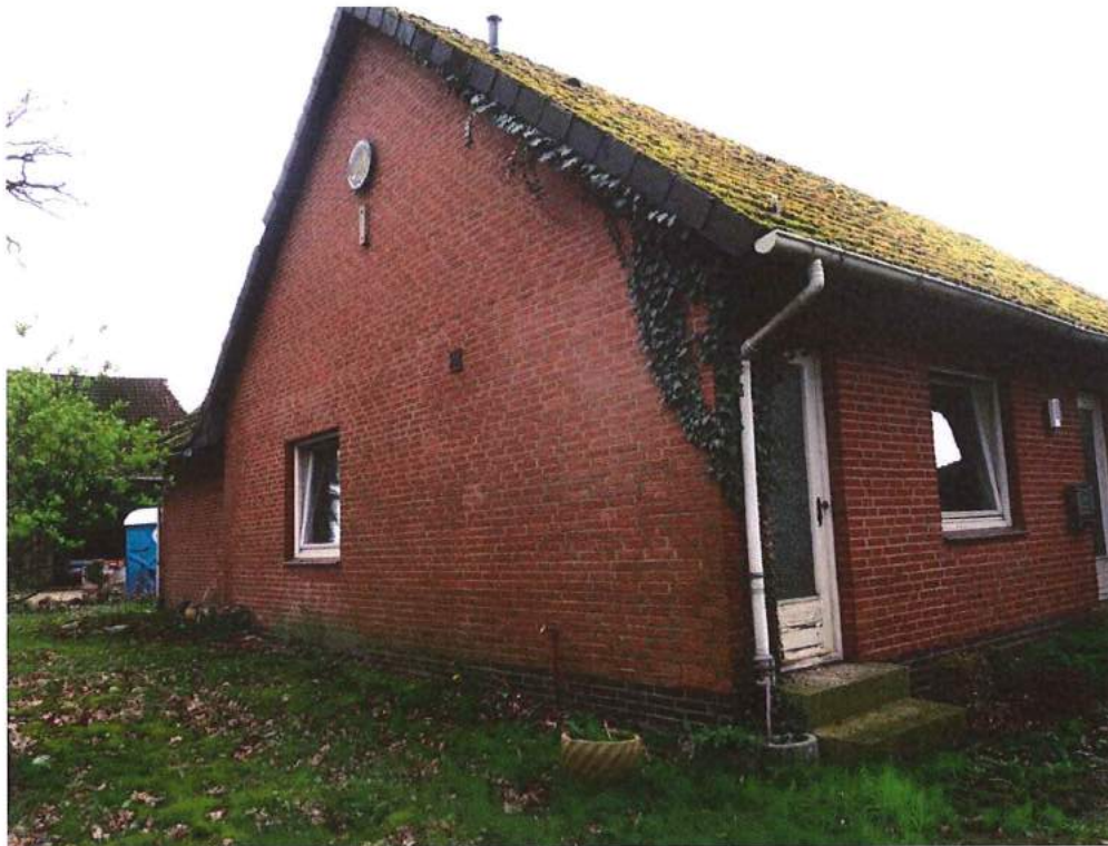
Wohnhaus von Nord-Westen
