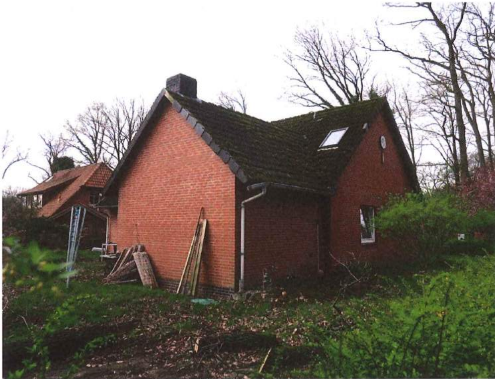
Wohnhaus von Nord-Osten
