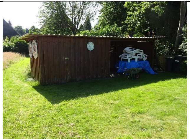
Unterstand mit Abstellraum
