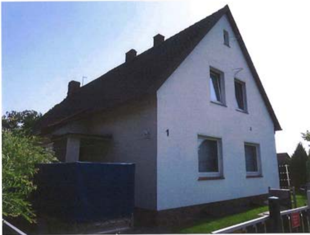
Wohnhaus von Westen
