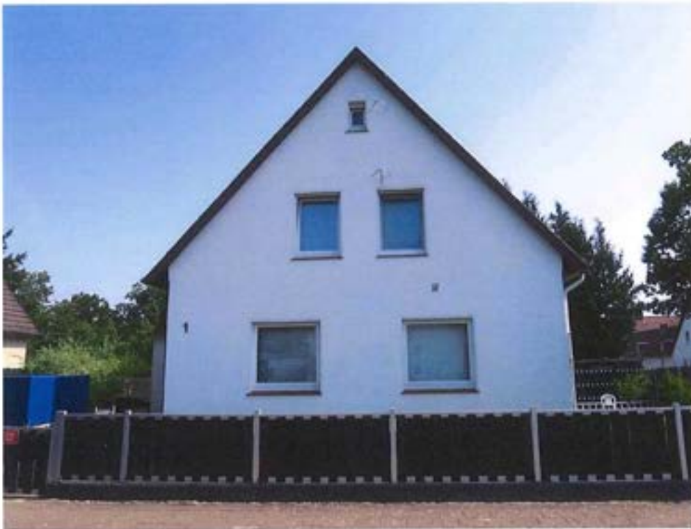
Wohnhaus von Süd-Westen
