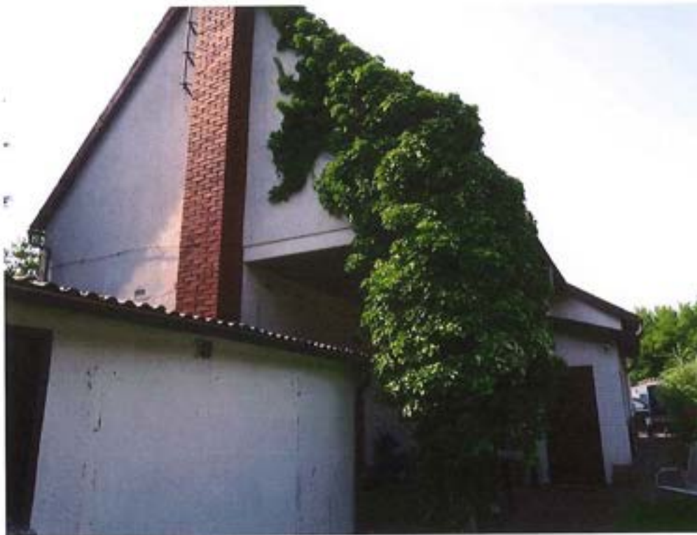
Wohnhaus von Nord-Osten
