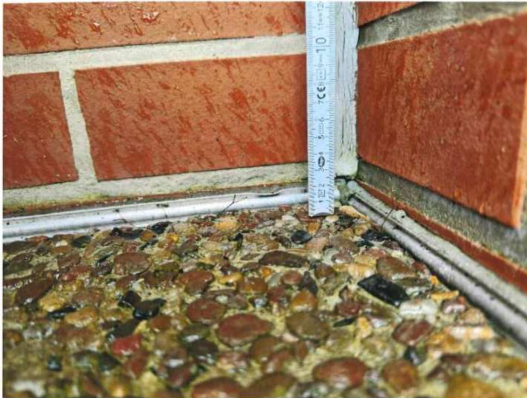
Bild 13: Aufkantungshöhe Abdichtung 1 - 2 cm über Belag
