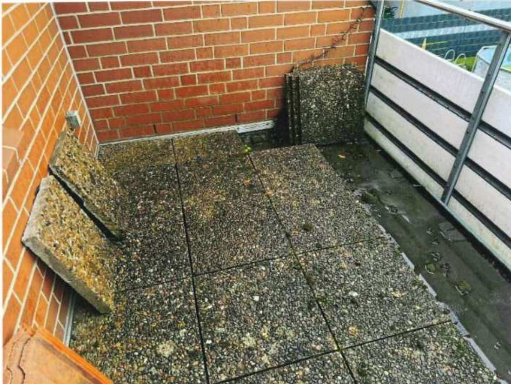
Bild 9: Übersicht Balkon mit südlicher Trennwand
