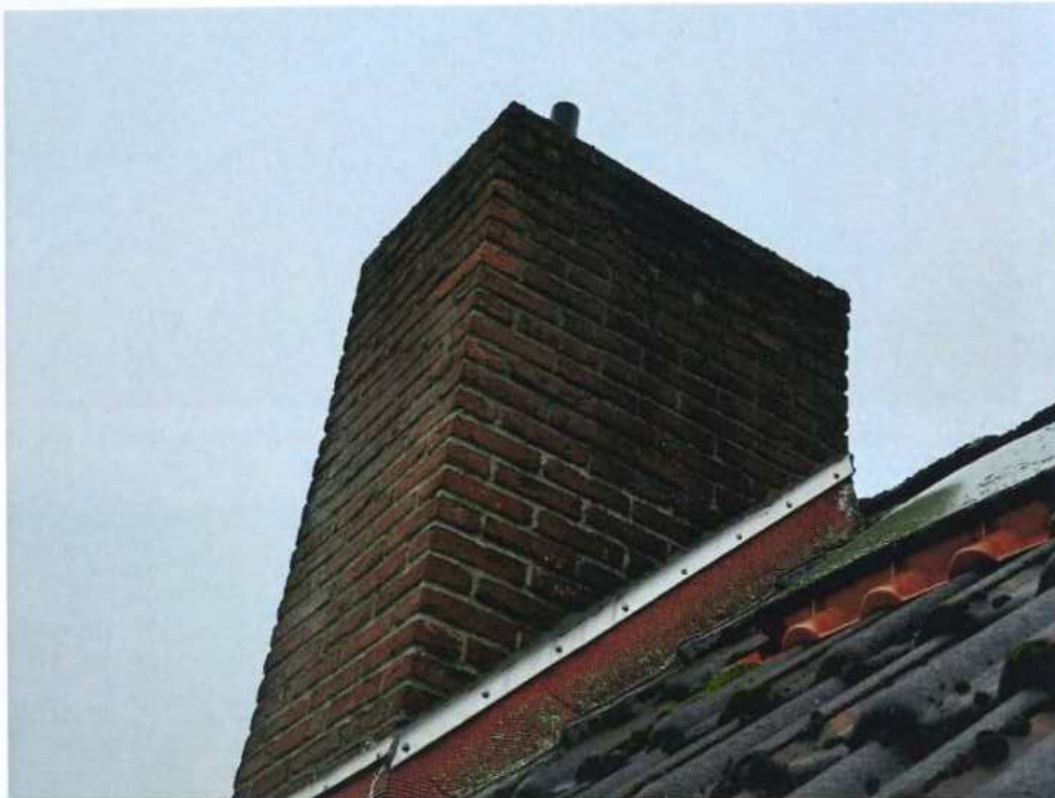
Bild 6: Schornstein mit Verblendmauerwerk und Betonabdeckplatte
