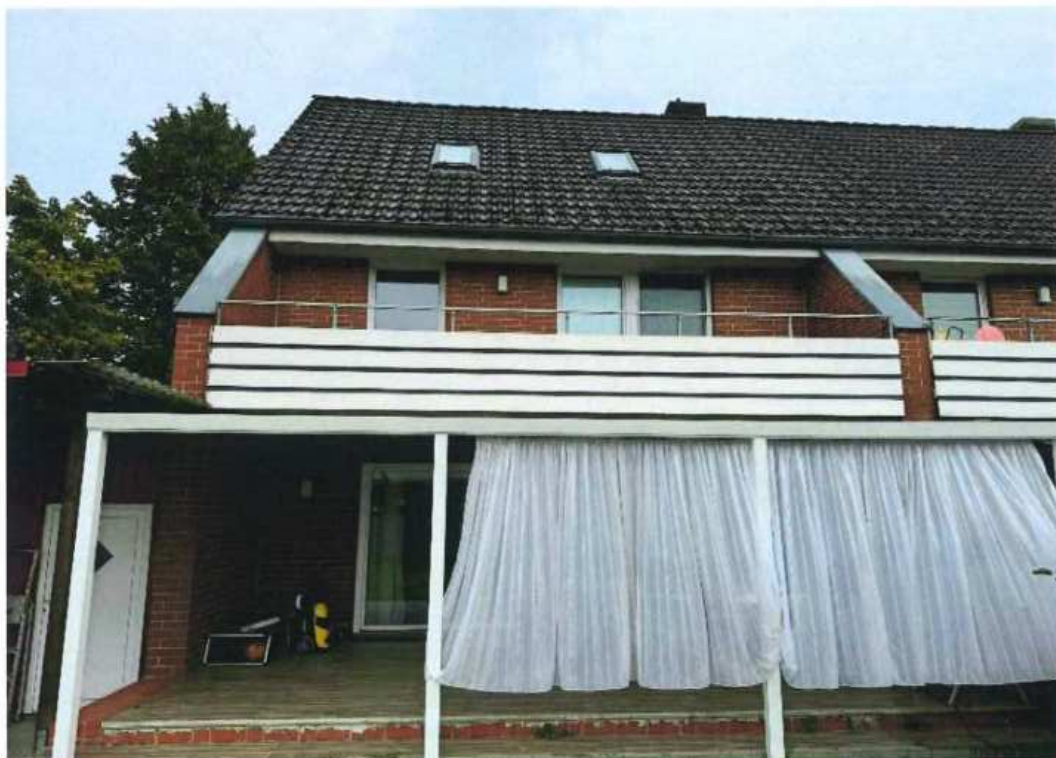
Bild 2: Gebäudeansicht von Westen, Garten, überdachte Terrasse, Balkon im OG
