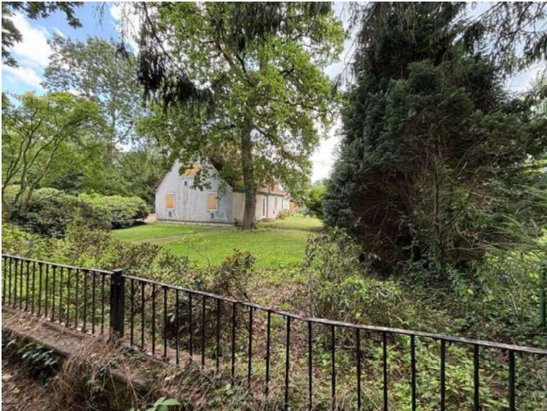
Bild 7 - Garten, Rückansicht, Baumbestand, Zaunanlage
