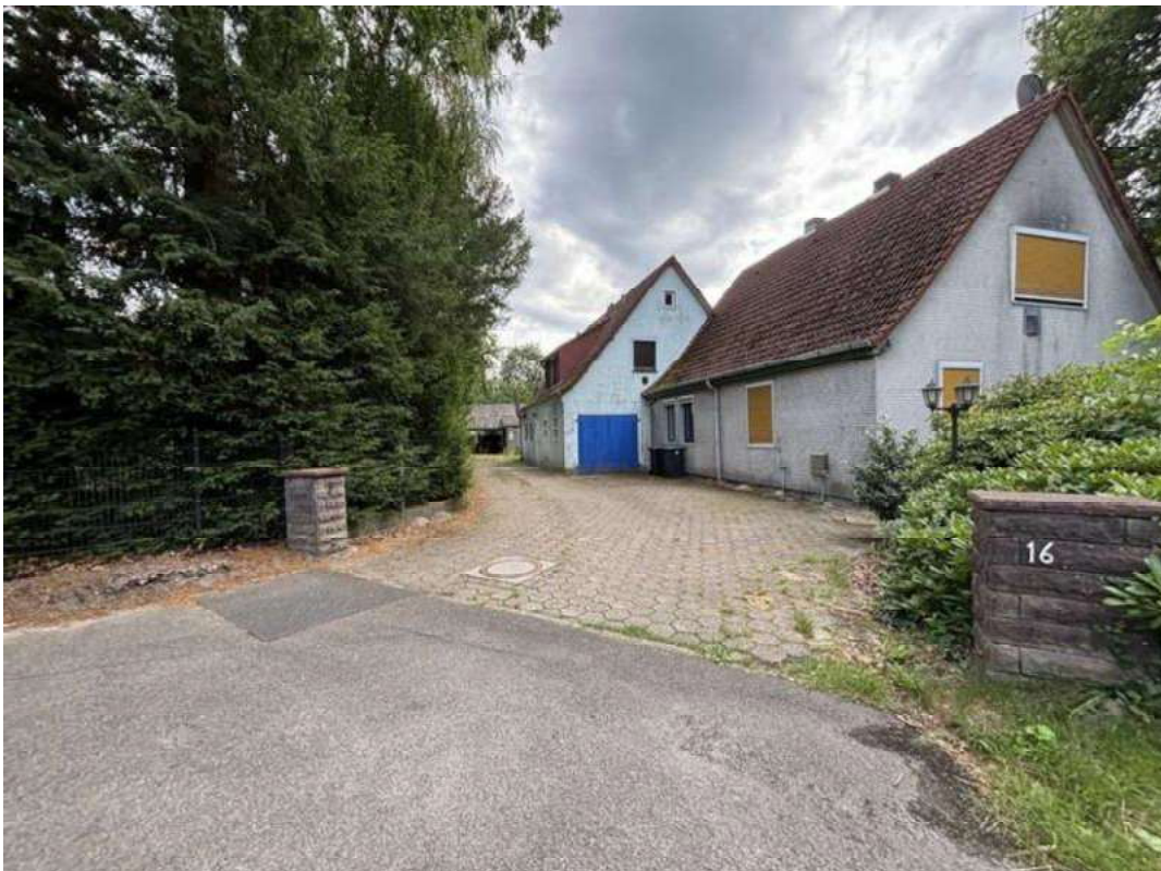
Bild 2 - Außenansicht, Zufahrt, Hofpflaster, Torpfeiler
