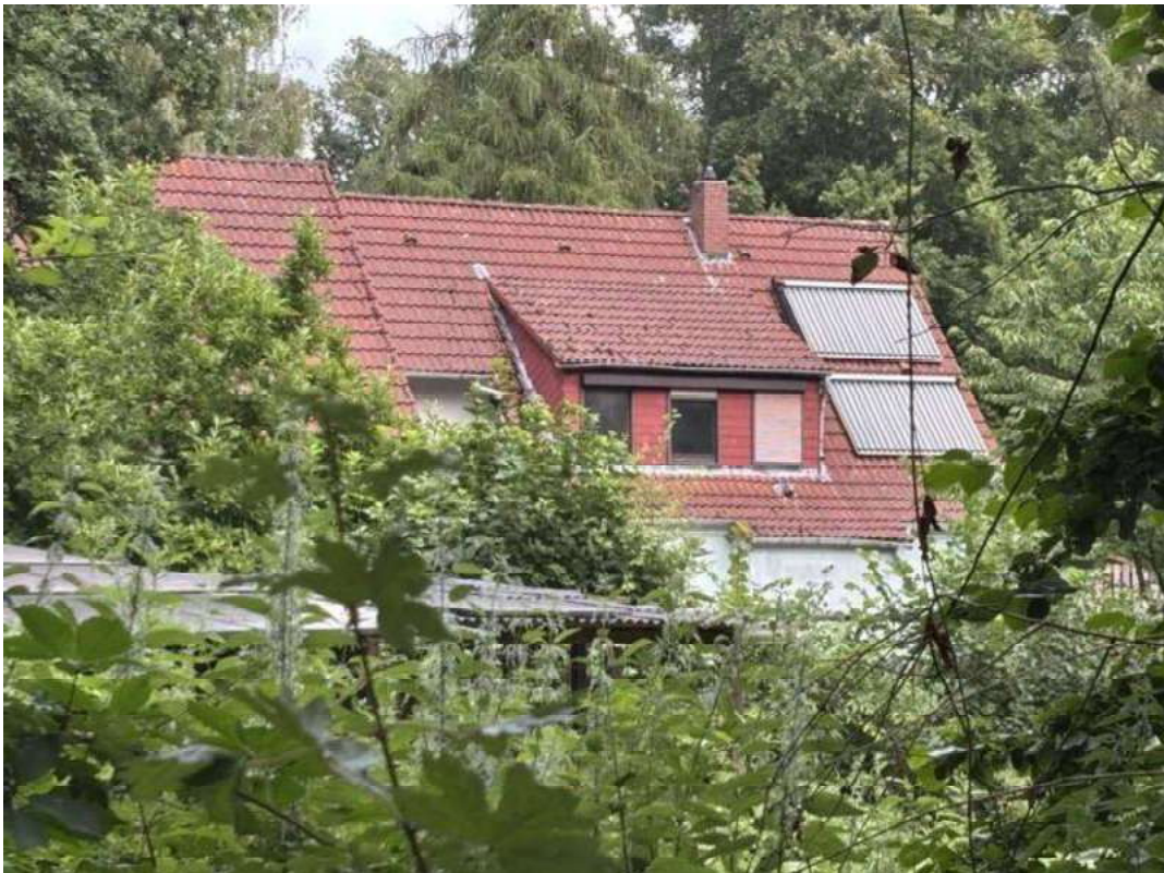
Bild 10 - Rückwärtige Dachfläche mit Schleppdachgaube, eingeschnittenem Balkon und Solarkollektoren
