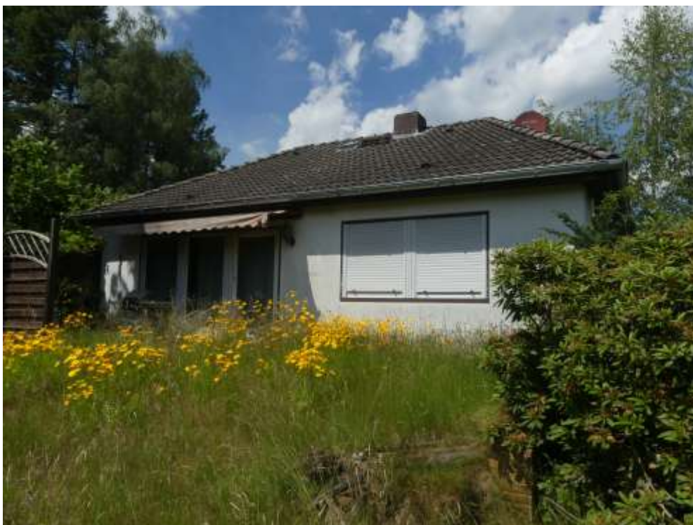
Südliche Gartenansicht mit Terrasse
