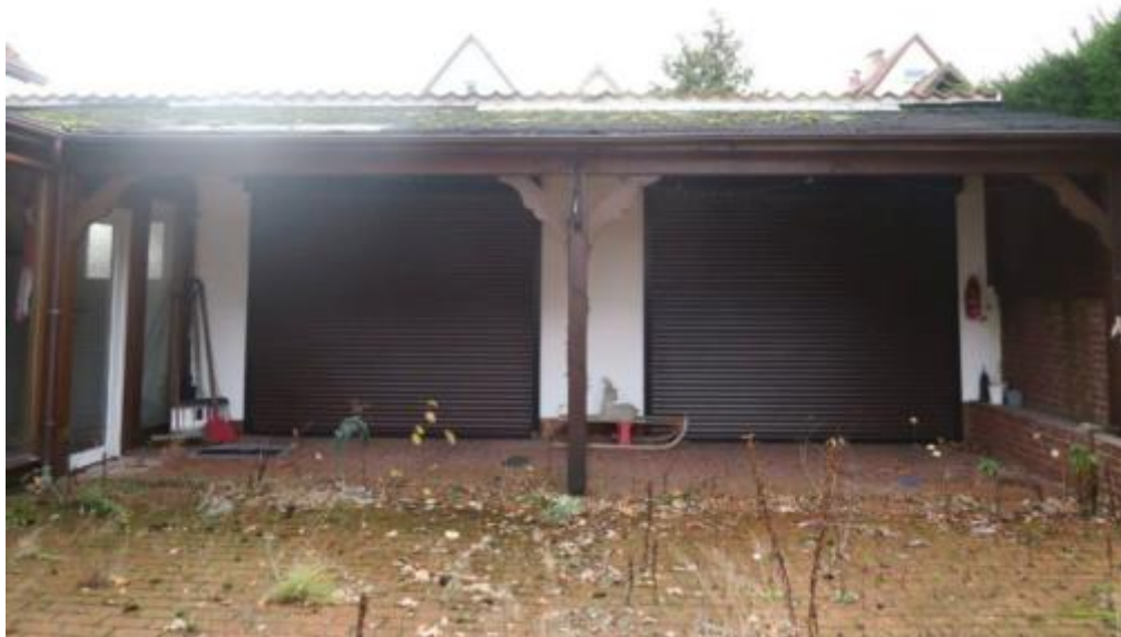
Garage von Norden
