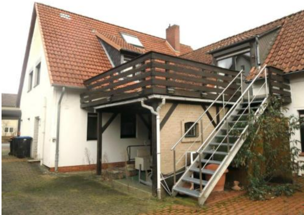
Wohnhaus und Carport von Süd-Westen
