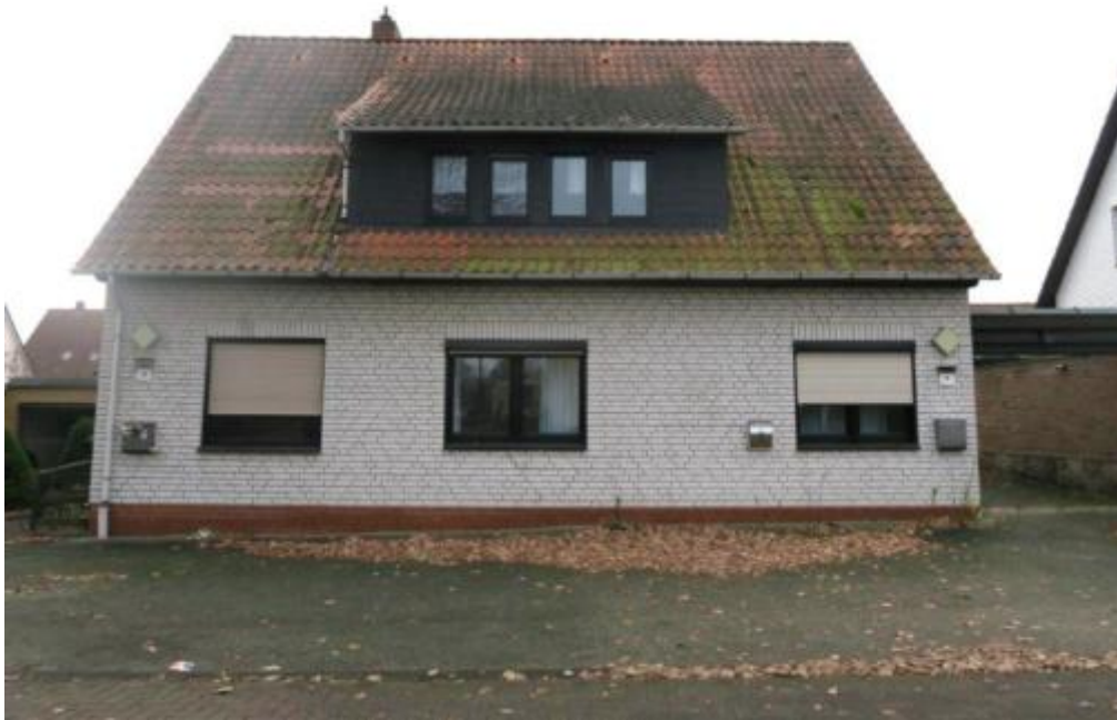
Wohnhaus von Norden
