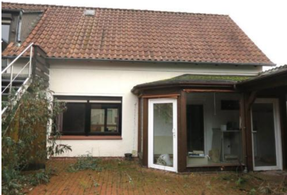
Wohnhaus von Westen
