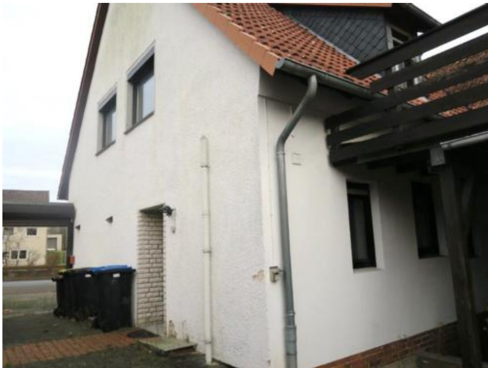
Wohnhaus von Süd-Westen
