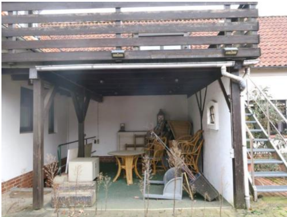
Carport von Westen
