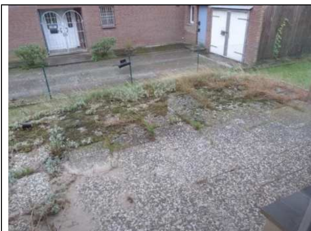
Terrasse am Haus
