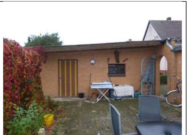
Ansicht von der Terrasse / Sitzecke
