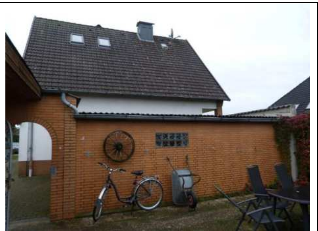
Ansicht von der Terrasse / Sitzecke
