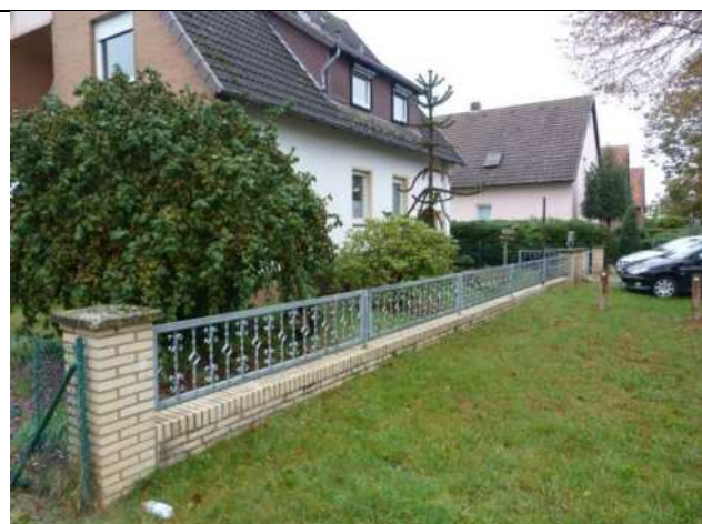
gemauerter Metallzaun zur Straße
