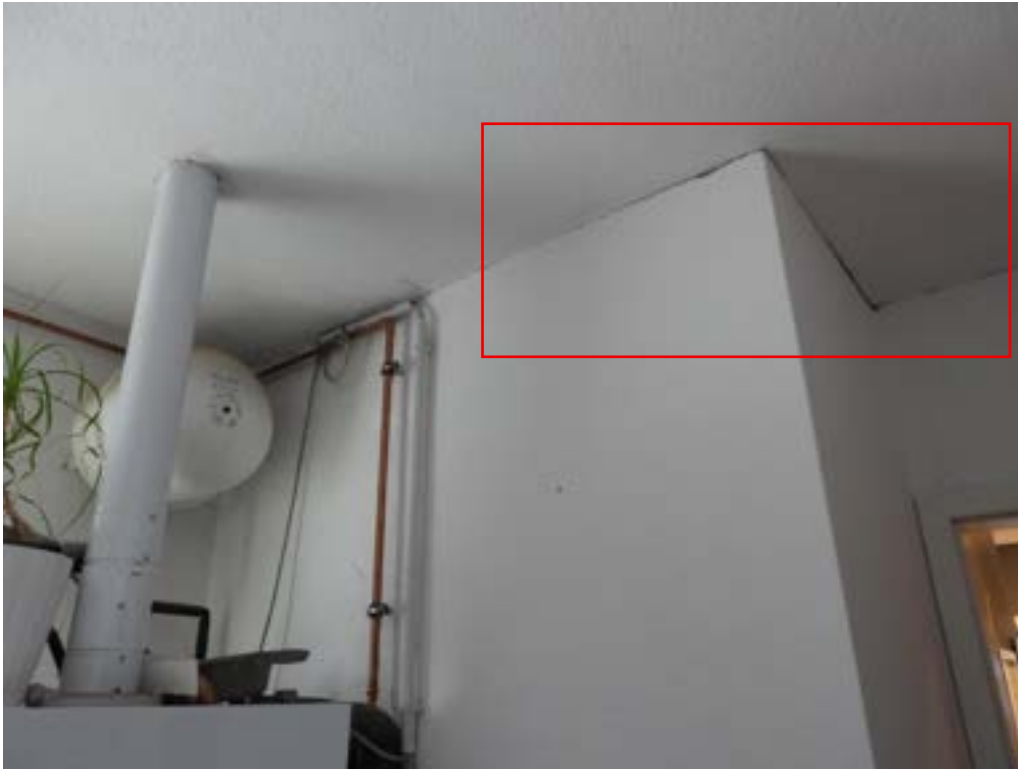
Hauswirtschaftsraum | Abriss Wand-/Deckenanschluss
