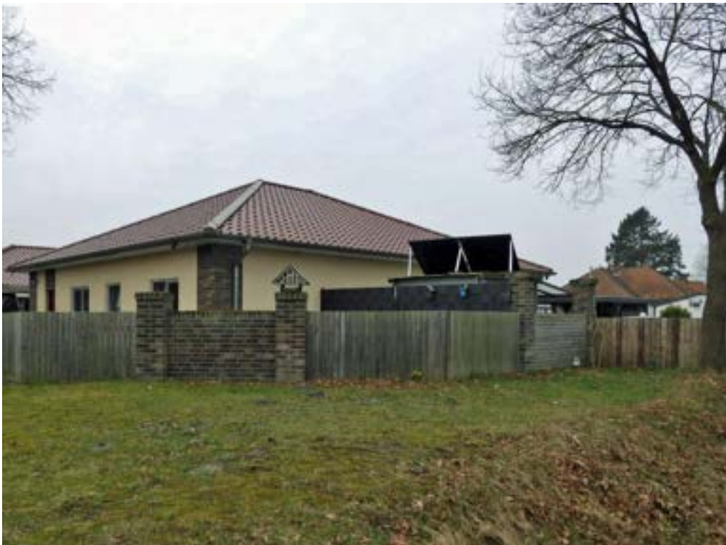
Einfriedung auf der Ost- und Nordseite
