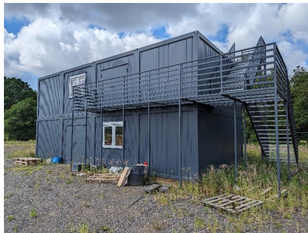
Ansicht von Nordosten
