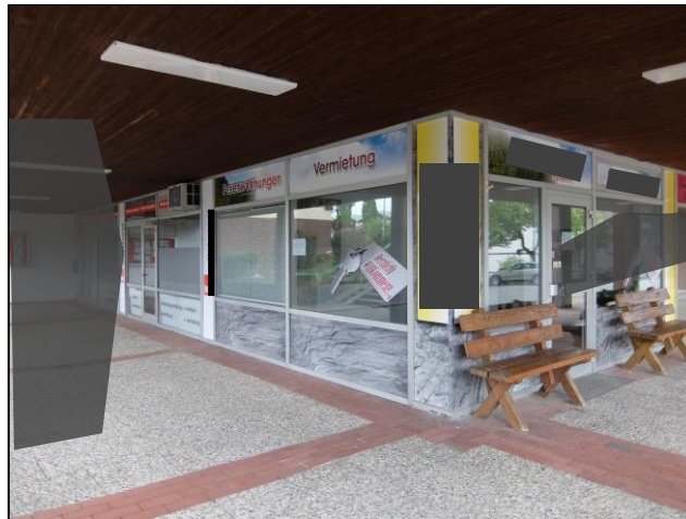
Ansicht von Süd-Ost
