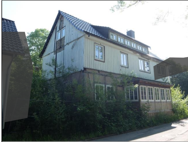
Ansicht von Süd-West
