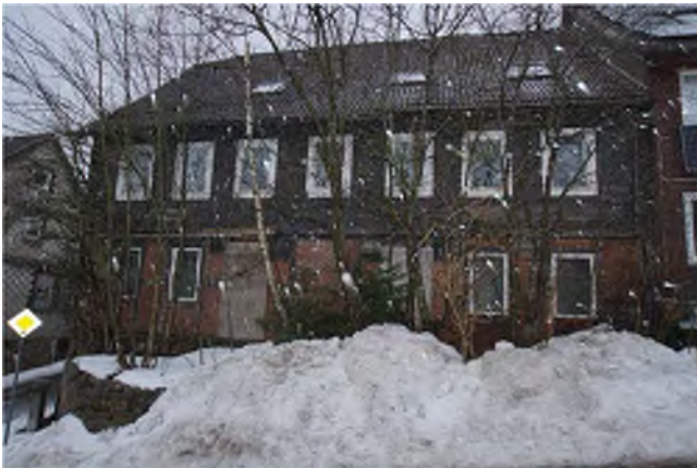
Bild Nr.: 5 Öffnungsverschluss mit Holzwerkstoffplatten.
