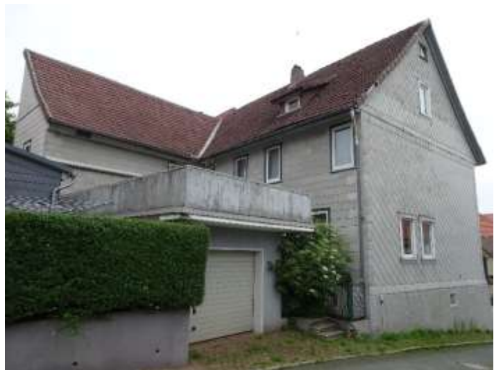
Westseite – Straßenansicht Faktoreigasse
