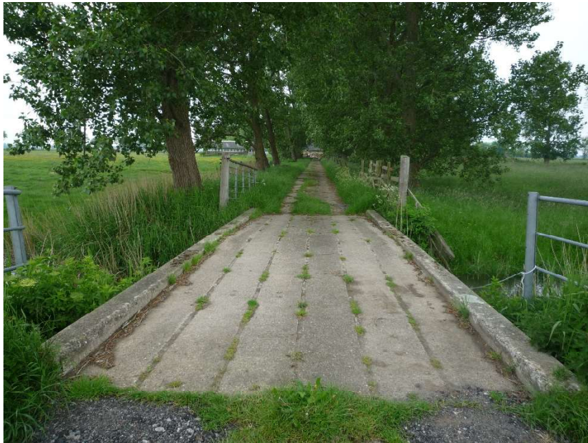
zu erneuernde Brücke
