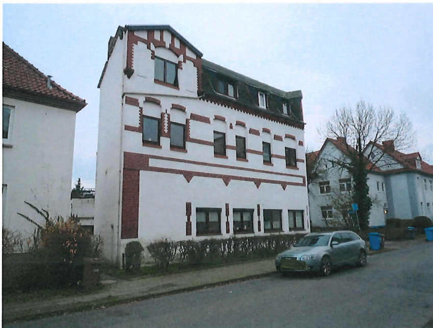
Wohnung Nr. 6 im Obergeschoss (Niedersachsenstraße)
