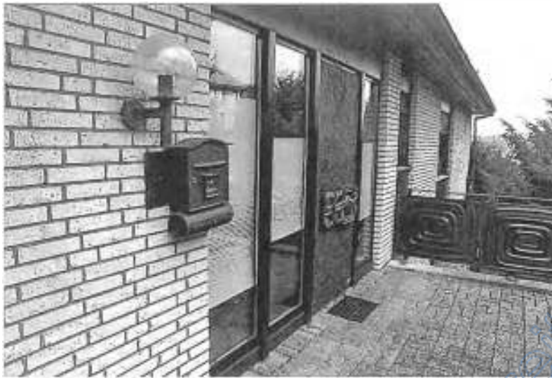
5 Hauseingang im Detail
