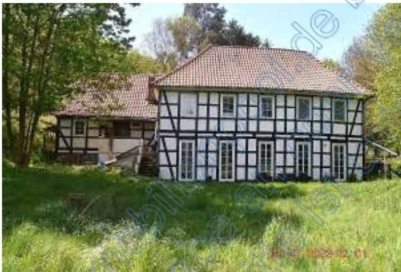
2 Ansicht aus Richtung Ost
