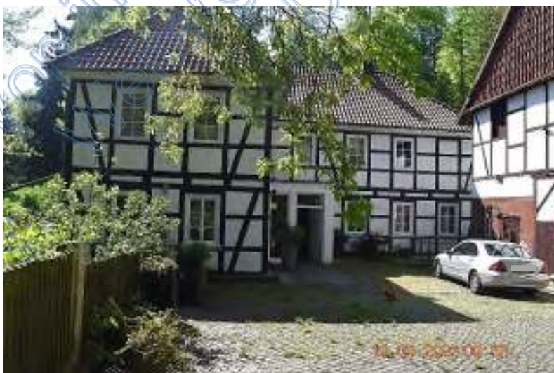
9 Wohngebäude aus Richtung Nord
