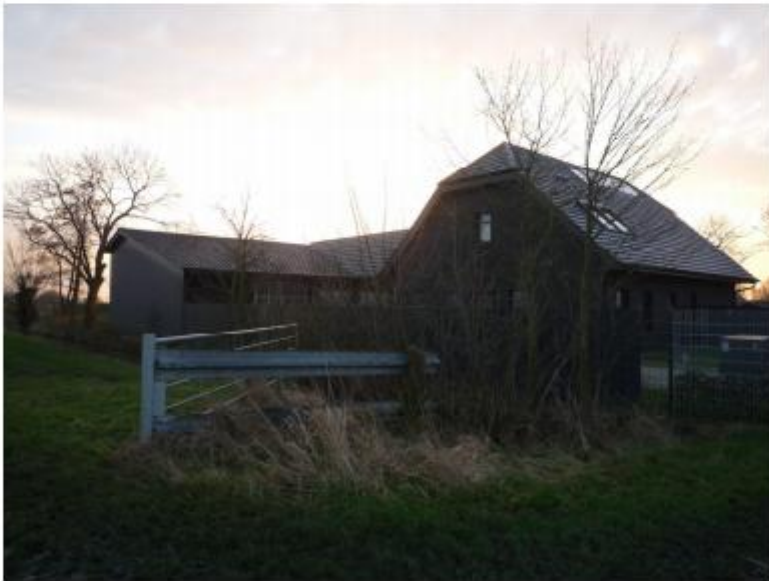
Wohnhaus mit Anbauten/Schuppen straßenseitig, Nordwestansicht
