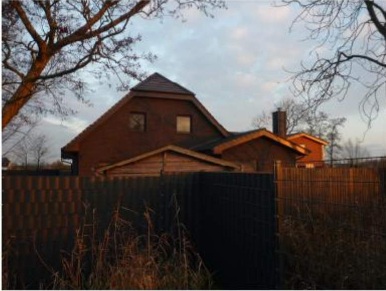
Wohnhaus straßenseitig, Südansicht
