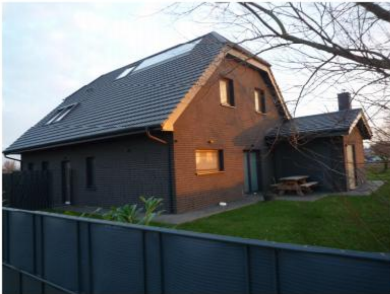
Wohnhaus mit Anbau straßenseitig, Süddwestansicht
