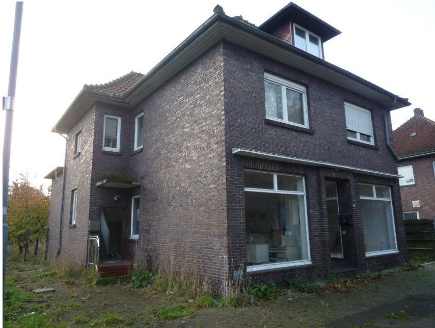
Wohn- und Geschäftshaus straßenseitig, Nordansicht
