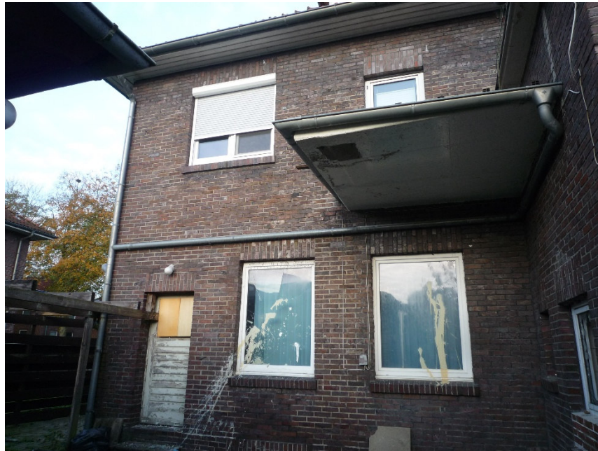
Wohn- und Geschäftshaus mit Balkon, Südostansicht
