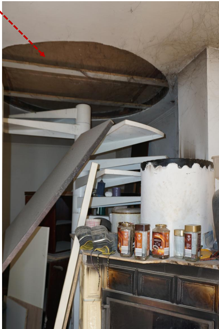
Wohnzimmer Decke runde Öffnung für Wendeltreppe
