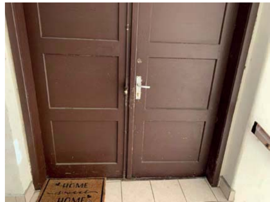
Zugang zur Tür 3
