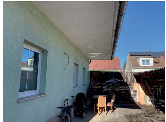
WGeb. 1: eingeschöziger Gebäudeteil (Fenster der Tür 1)
