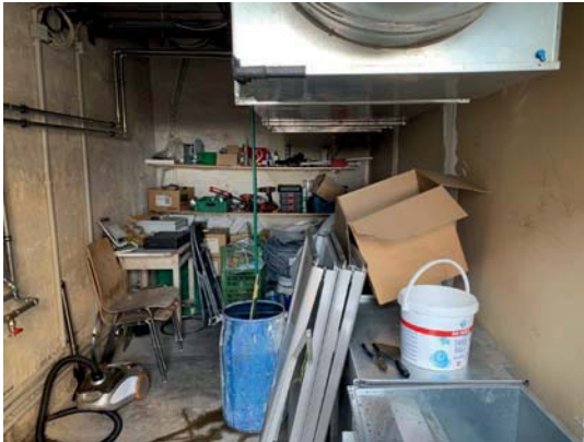
Haustechnikraum (vom Innenhof erreichbar)
