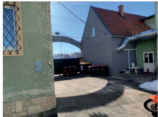
Innenhof mit Einfahrtstor straßenseitig und links WGeb. 2 und rechts WGeb. 1
