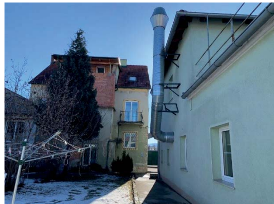
WGeb. 1: eingeschößiger Gebäudeteil Wohnungen im EG (Tür 1 und Tür 2)
