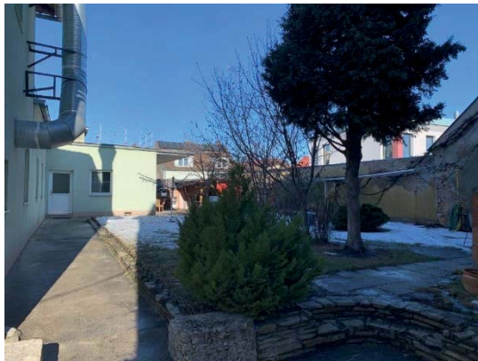
WGeb. 1: eingeschöziger Gebäudeteil
