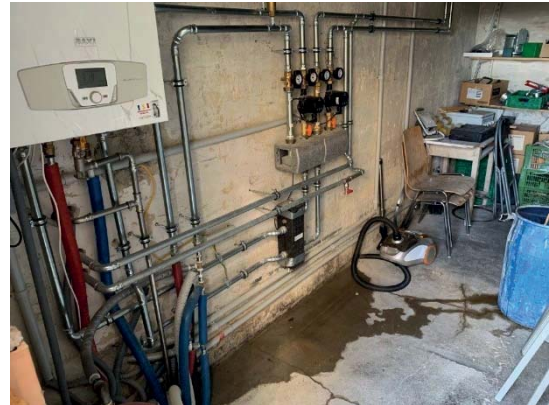
Haustechnikraum (vom Innenhof erreichbar)
