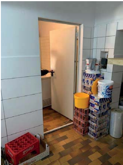
Zugang zu weiterem Vorraum
