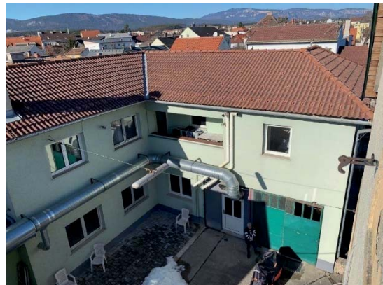
WGeb. 1: EG Geschäftslokal und Haustechnik und Garage rechts sowie 1. Stock Wohnungen
