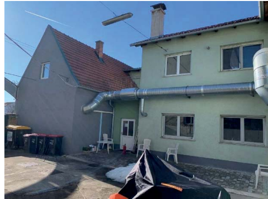
WGeb. 1: links eingeschößiges Gebäude und rechts zweigeschößiges Gebäude
