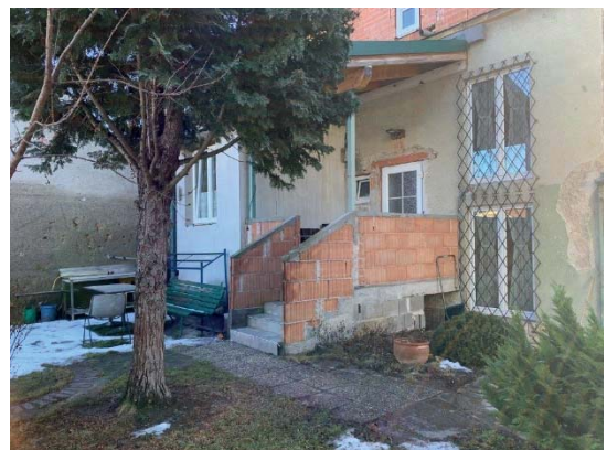
Eingang zu WGeb. 2 Tür 7, Zugang zur Tür 8 seitlich
