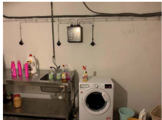
Kellerraum mit Waschküche
