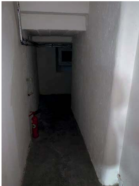
Keller unter Abstellraum
