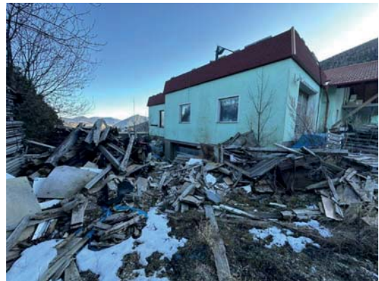
Bild 14 - Zufahrt Garage Keller (derzeit nicht passierbar)
