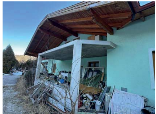
Bild 10 – Terrasse (lt. Plan Wintergarten) südwestseitig
