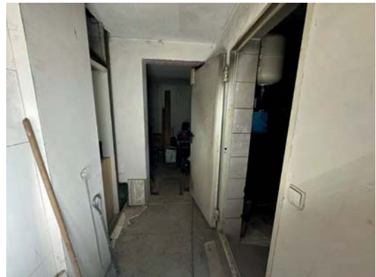
Bild 32 – rechts Heizraum, geradeaus Holzlager
