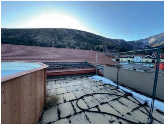
Bild 73 – Dachterrasse und Dachdeckung
