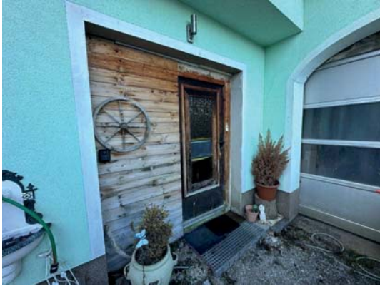
Bild 45 – Eingang zum Wohngebäude
