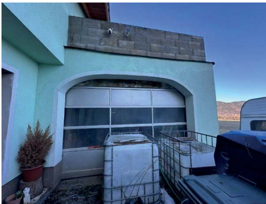
Bild 7 – Garage neben Eingangsbereich
