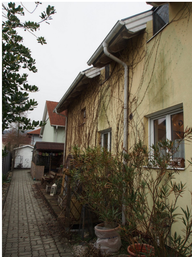
Foto 4 Ostansicht Haus 8 (beim Zugangsweg)
