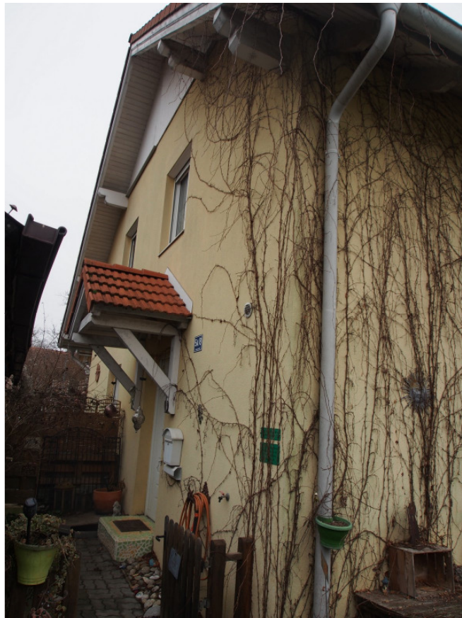
Foto 6 Südwestansicht Haus 8 Eingangsbereich
