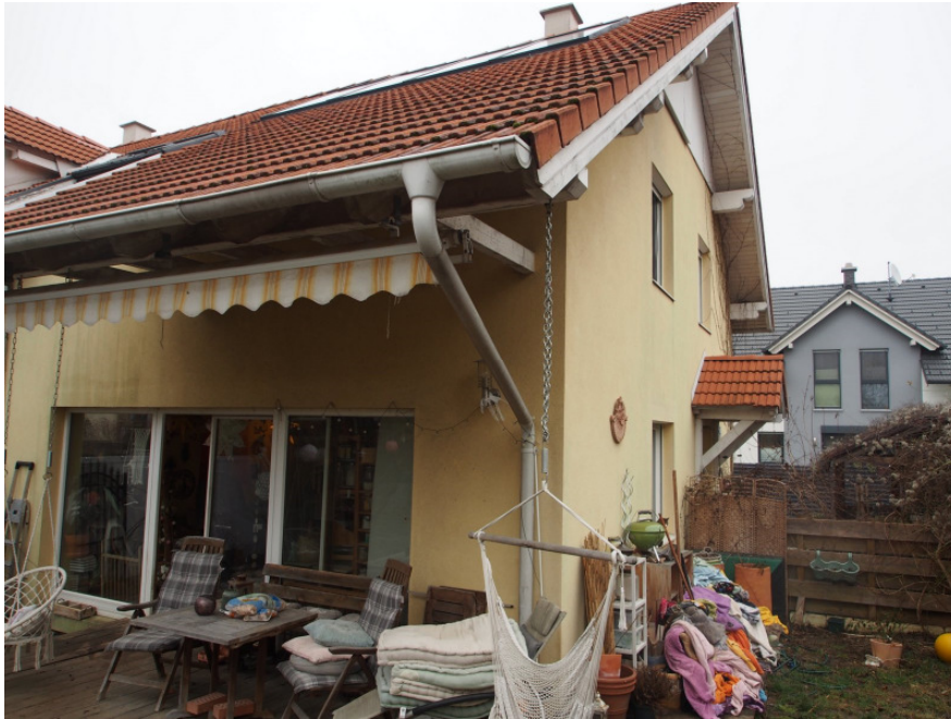
Foto 7 Südwestansicht Haus 8 im Garten
