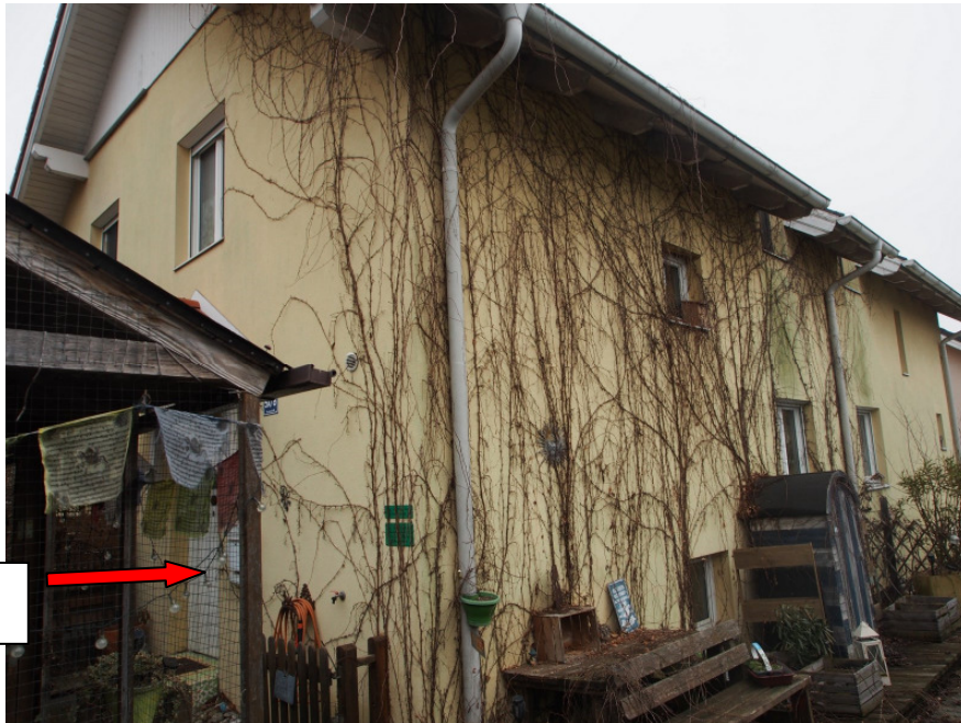
Foto 3 Südostansicht Haus 8 (mit Haus 7 im Hintergrund) beim Zugangsweg
