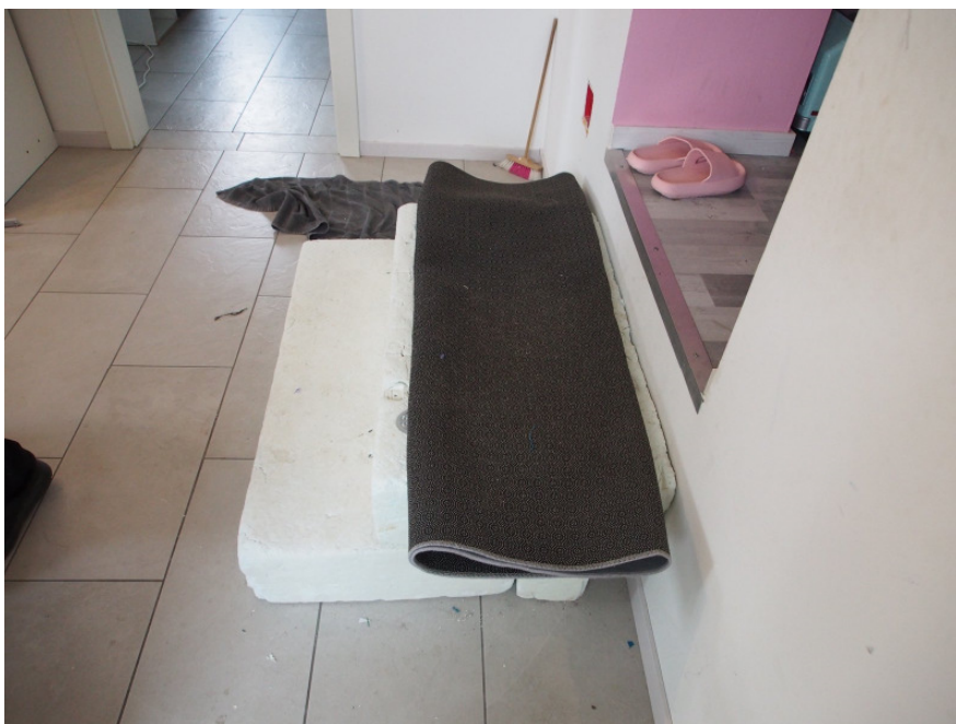
Foto 21 Zugang zu Zimmer 1 von der Wohneinheit 2
