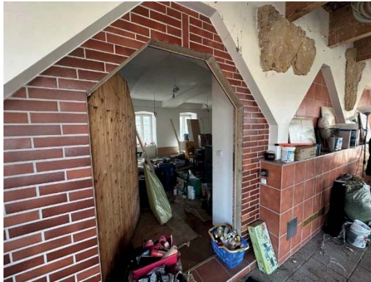
Zugang zu Altbau
