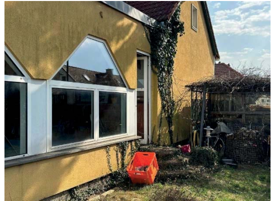
Eingang in Hallenbad, rechts Altbau
