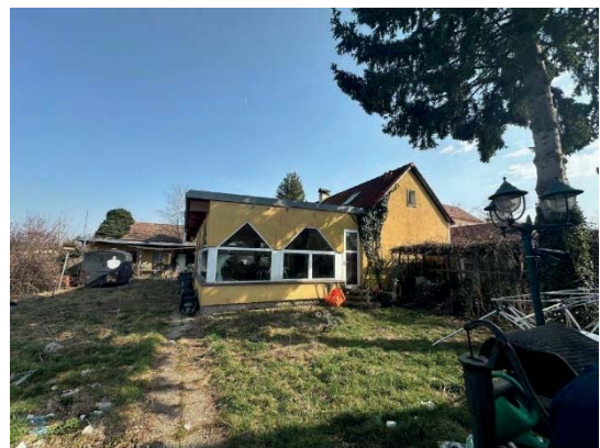
Vom linken Nachbargrundstück aus. Die gelbe Wand stellt die Grundstücksgrenze dar. Hier sollte eine Feuermauer errichtet werden.
