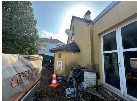
Ostseite mit polygonal angebautem Heizraum
