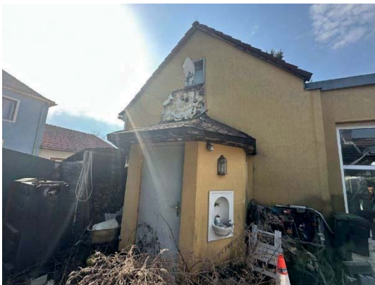
Ostfassade mit Heizhaus
