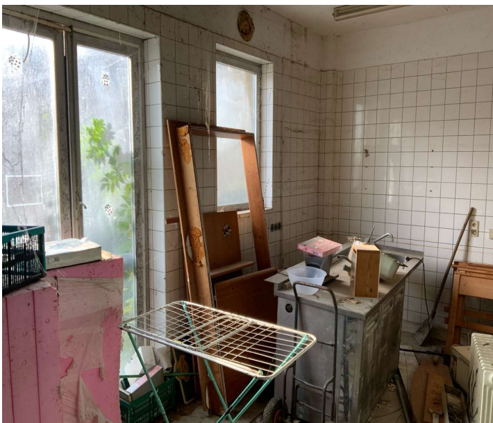
Abstell- und Küchenbereich hinter der Schank
