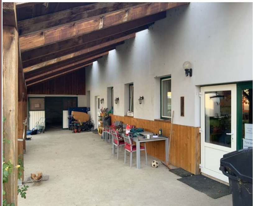
Schleppdach-Konstruktion zur Überdachung des Vorplatzes des Stüberbereichs
