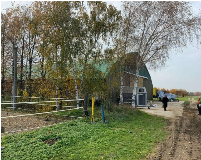
Blick von Nordosten auf die Halle nach Südwesten
