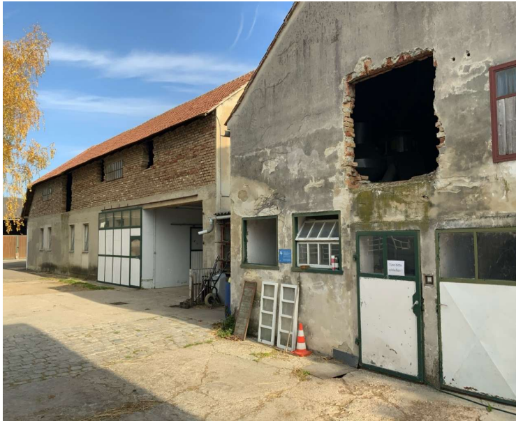
Außenansicht – westliche Gebäudefront der vorderen Hofgebäude und des 10er-Stalles
