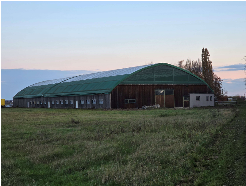
Blick von Südwesten auf die Rundbogen-Zelthalle nach Nordosten
