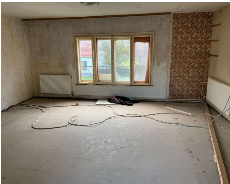
Wohnzimmer im Obergeschoss über Hofdurchfahrt - Straßenseite
