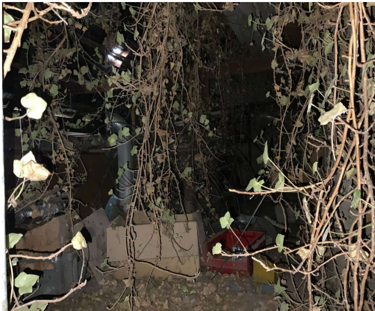
Blick in den Dachboden des Garagentraktes
