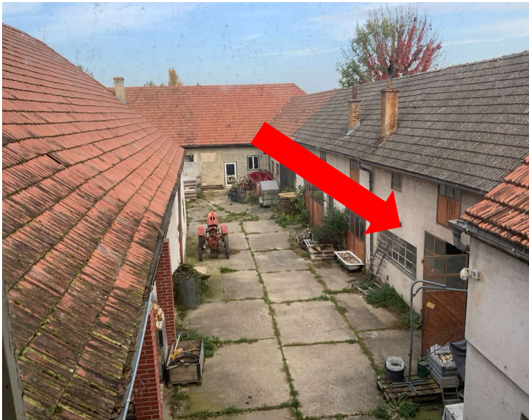
Blick vom Wohntrakt auf den Gebädetrakt im vorderen Hofbereich
