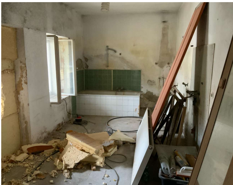
Ehemaliges Bad im Erdgeschoss im alten Wohntrakt
