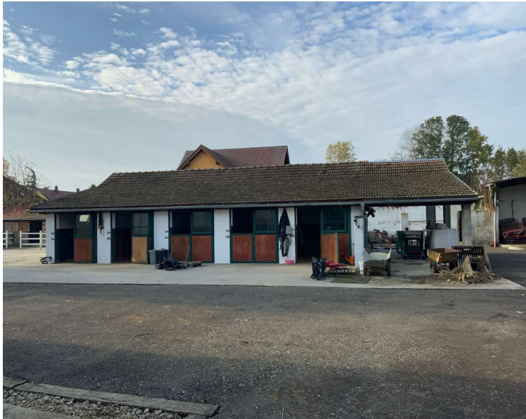
Blick auf die östliche Gebäudefront mit den fünf Pferdeboxen
