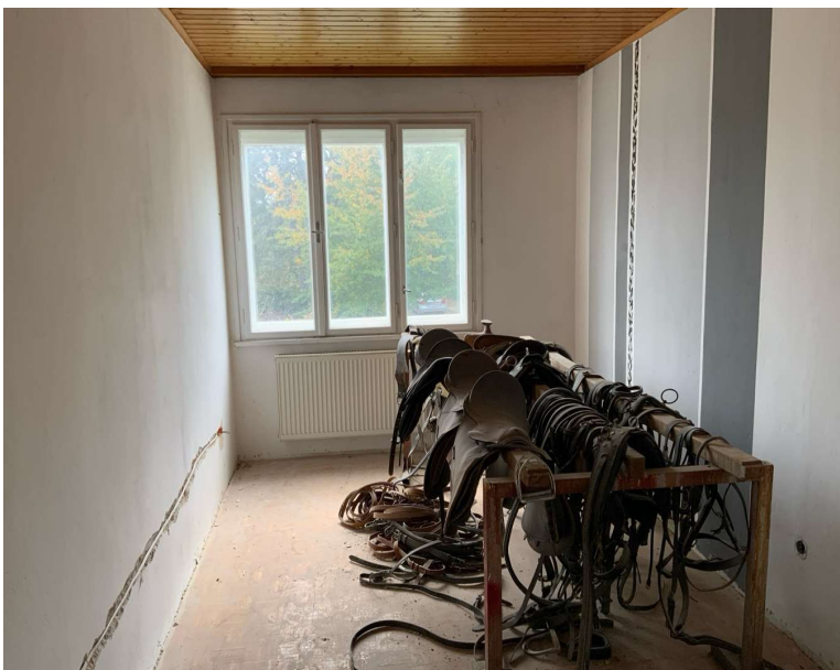
Kabinett im Obergeschoss – Sattellager - südseitig
