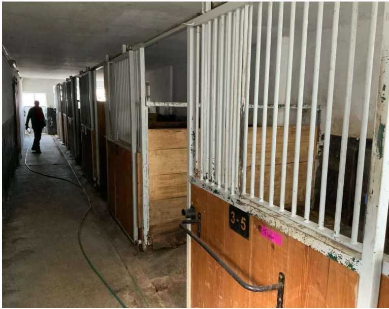
Fünf Pferdeboxen im alten Stalltrakt mit Aufstallung aus Stahl-Holzkonstruktion
