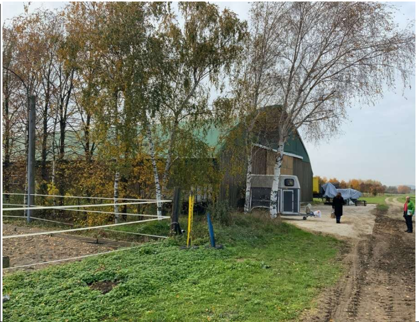
Blick von der nördlichen Längsgrenze auf die Rundbogen- Zelthalle nach Südwesten
