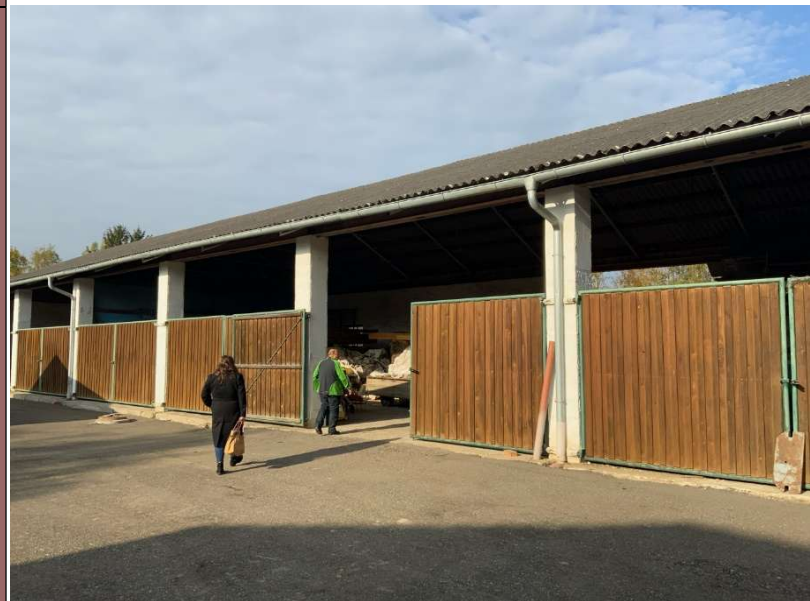
Lager- und Einstellhalle - südliche Gebäudefront
