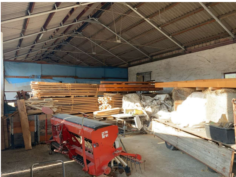
Innenansicht Lager- und Einstellhalle – Westseite
