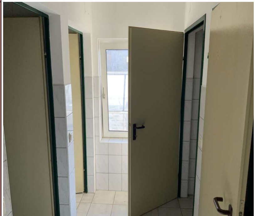
Zugangsbereich zu Duschen und WCs im Sanitärbereich
