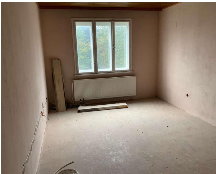
Kinderzimmer im Obergeschoss - südseitig
