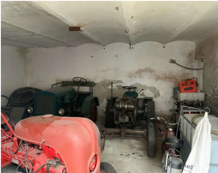
Ehemaliger Stall – dzt. als Einstellbereich von alten Traktoren genutzt
