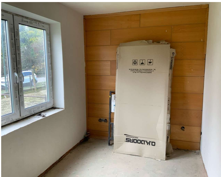
Weiteres Zimmer im westlichen Bereich des alten Wohntrakts – Erdgeschoss straßenseitig
