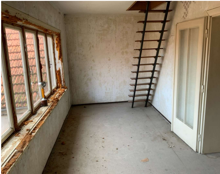
Gang-/Vorzimmerbereich im Obergeschoss - Hofseite
