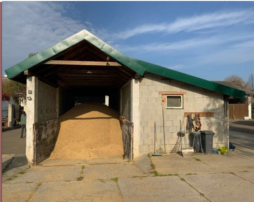
südliche Gebäudefront Fahrsilotrakt mit rechts angebautem Pferdestall
