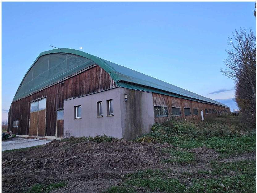
Blick auf die südöstliche Gebäudefront der Rundbogen- Zelthalle
