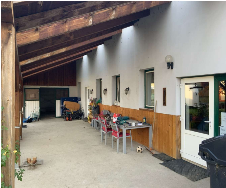
Schleppdach-Konstruktion zur Überdachung des Vorplatzes
