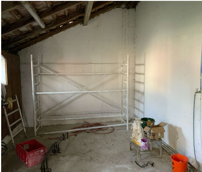
Vorraum des Stallbereichs – Ausbau und Instandsetzungsarbeiten dzt. im Gange
