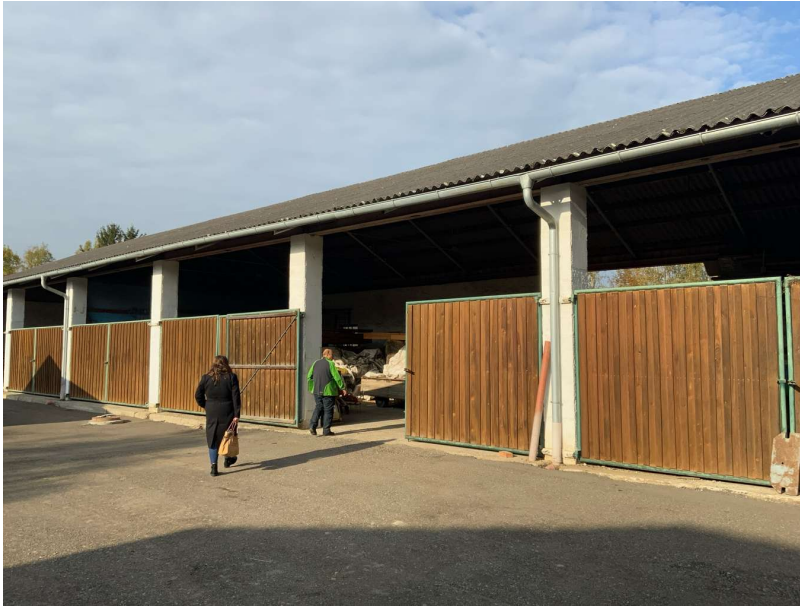
Blick auf die südliche Längsseite mit Einfahrtstoren (Drehtore mit Holzbeplankung)
