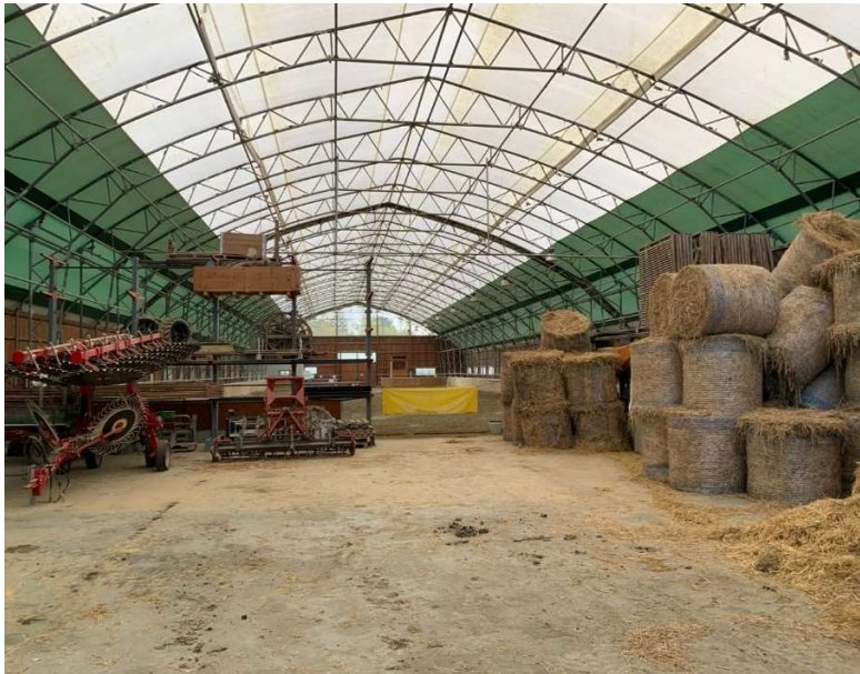
Blick auf den nördlichen Teil der Lagerhalle – Maschinen- und Betriebsmittellager
