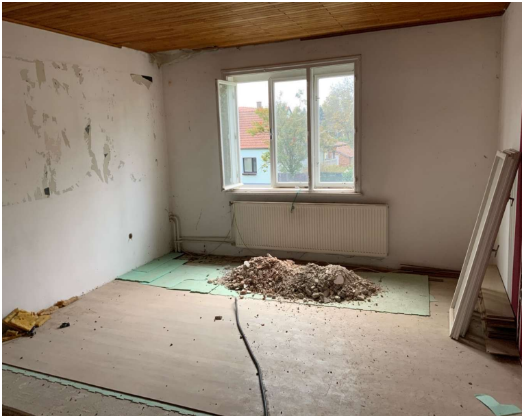
Zimmer im Obergeschoss - südseitig
