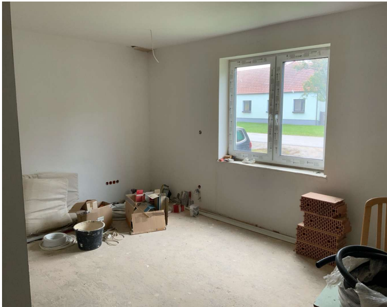
Zimmer im südlichen Bereich alter Wohntrakt – Erdgeschoss strassenseitig
