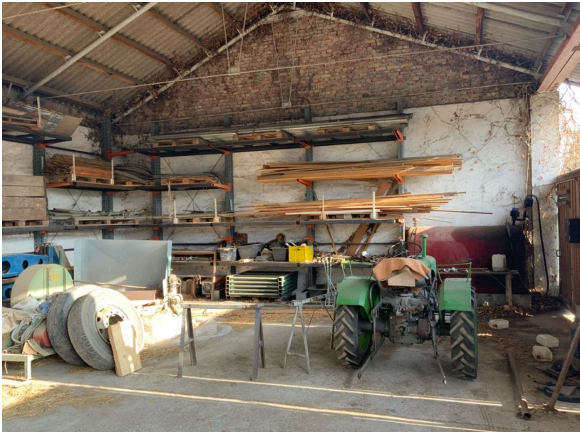
Innenansicht Lager- und Einstellhalle – Ostseite
