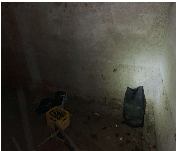
Kellerraum unter Sanitärbereich
