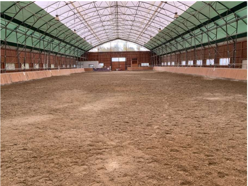
Detailansicht Innenraum Zelthalle - Reitplatz mit Aufbau aus Quarzsand und Zellulosefaser
