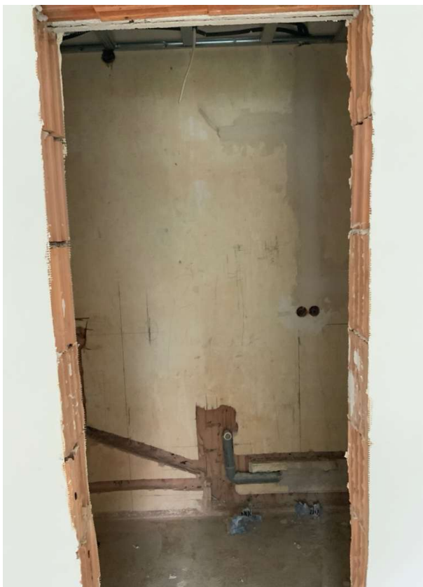
Türdurchbruch zu geplantem Bad im alten Wohntrakt
