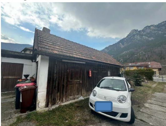
Rechtes Nebengebäude mit Blick zur Straße
