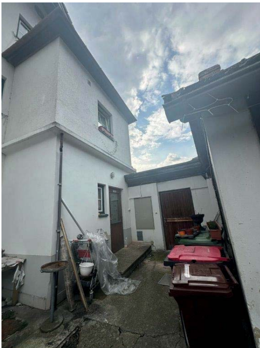
Rechter Teil: Eingang in Wohnung im EG
