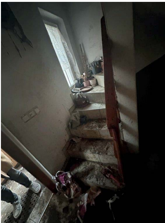
Aufgang in die Mansarde gefliest
