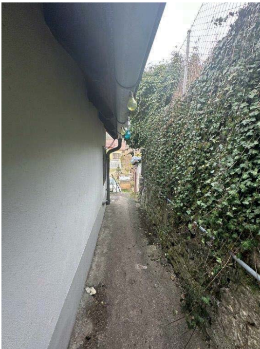
Zugang zur Wohnung im OG hinter dem Haus
