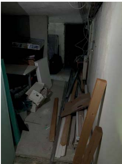
Zugang zu Kellerflächen Bestandsgebäude
