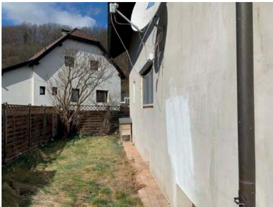
Linker Grundstücksbereich, nahe Garage
