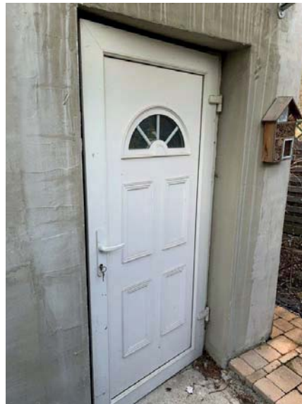
Zugang zu Abstellraum
