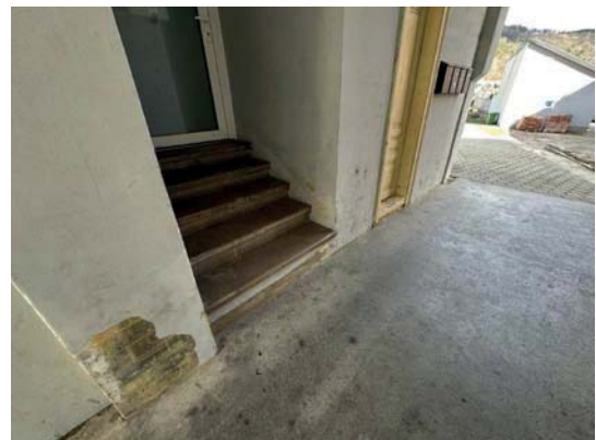
Zugang zum allgemeinen Stiegenhaus
