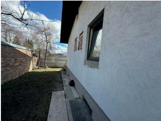
Mauerwerk (Fenster wurden zugemauert)
