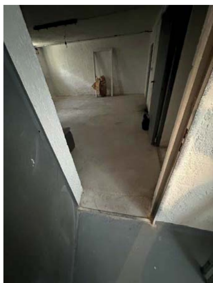
Zugang zu weiterem Kellerraum
