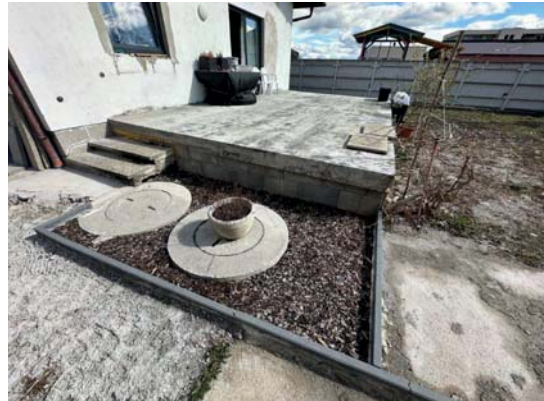
Terrasse/ Zugänge nicht fertig
