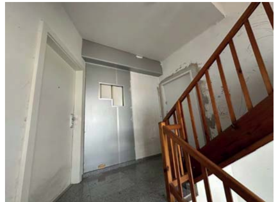
Zugang zu Top 1 und Top 2
