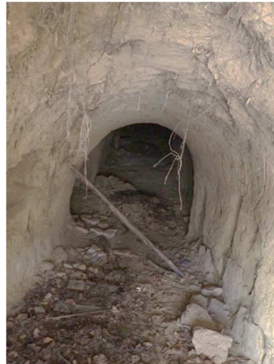
Kellerröhre der Erdkellers
