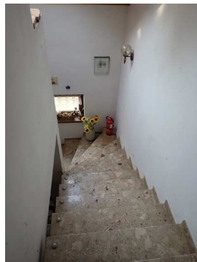
Stiegenanlage in das Kellergeschoß
