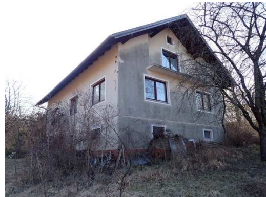
Nordfassade und Ostfassade
