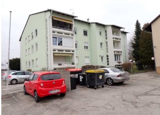
Nord- und Westfassade
