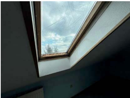
Bild 5: Verfärbungen Fensterrahmen
