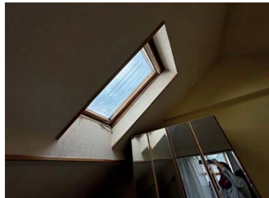
Bild 6: Verfärbungen Fensterrahmen
