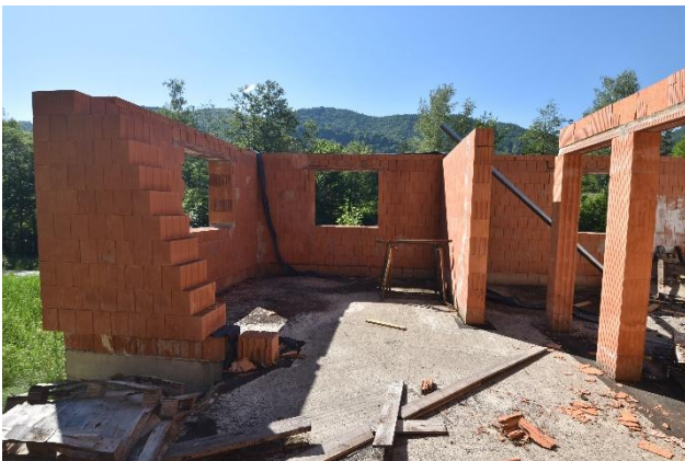
Foto 35: Wohnhaus Erdgeschoss – Zubau
