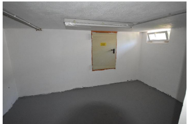
Foto 30: Wohnhaus KG – Kellerraum
