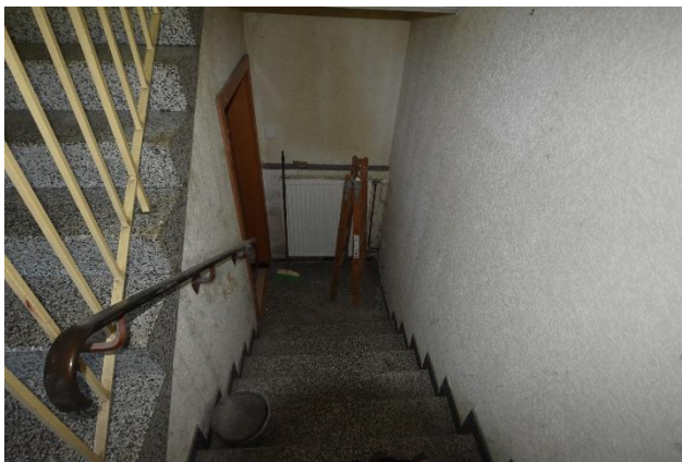
Foto 27: Stiege in das Kellergeschoss
