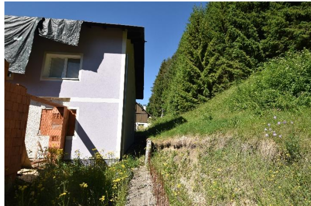
Foto 6: Gartenansicht Wohnhaus & Stützmauer
