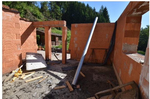
Foto 34: Wohnhaus Erdgeschoss – Zubau
