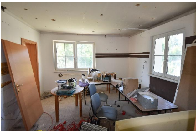
Foto 13: Wohnung Erdgeschoss – Küche
