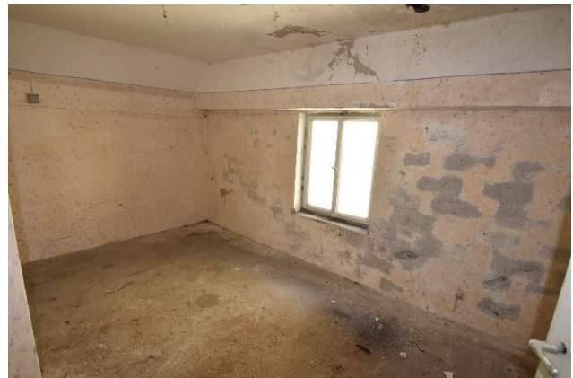
Foto 42: Wirtschaftsgebäude DG – Werkstatt
