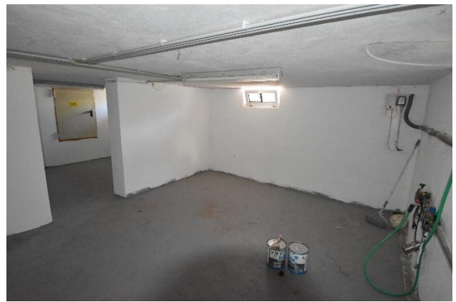
Foto 28: Wohnhaus KG – Kellerraum
