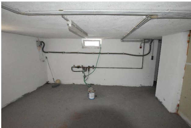
Foto 29: Wohnhaus KG – Kellerraum
