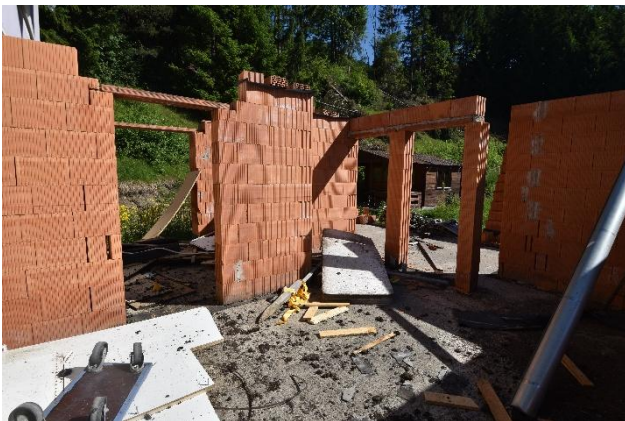
Foto 33: Wohnhaus Erdgeschoss – Zubau
