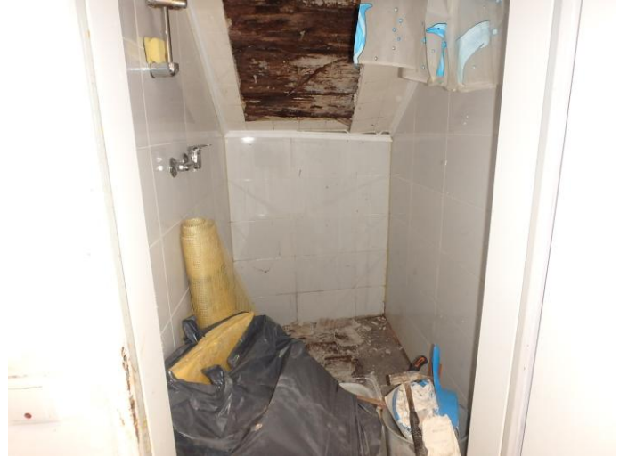
Abstellraum im EG unter der Stiege
