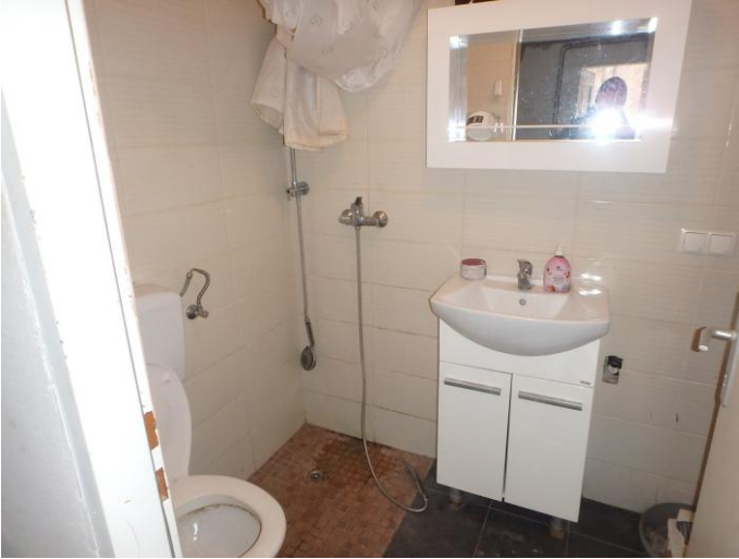
Bad im Zubau
