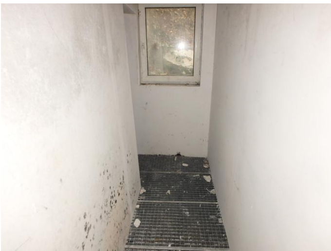
Gang zum Kellerraum
