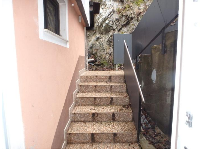
Außenzugang ins OG
