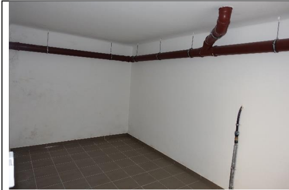
Abteil 3: Boden: Fliesen; Wände und Decke: verputzt und gemalt;
