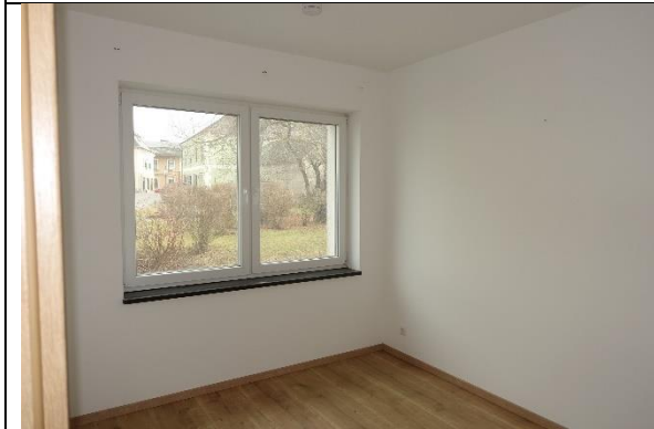
Zimmer: Boden: Holzdielenboden; Wände und Decke: verputzt bzw. gespachtelt und gemalt;
