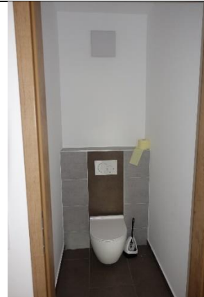
WC: Boden: Fliesen; Wände: teilw. verputzt bzw. gespachtelt und gemalt, teilw. Fliesen; Decke: verputzt bzw. gespachtelt und gemalt; Sanitär-ausstattung: 1 Hänge-WC mit Unterflurspülkasten; 1 Elektrolüfter;
