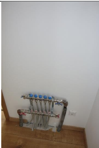
Heizungsverteiler-Fußbodenheizung
