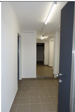
Vorraum: Boden: Fliesen; Wände und Decke: verputzt und gemalt;
