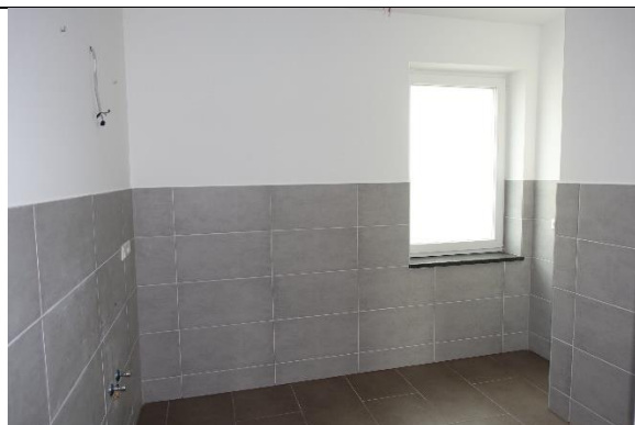
Bad: Boden: Fliesen; Wände: teilw. verputzt bzw. gespachtelt und gemalt, teilw. Fliesen; Decke: verputzt bzw. gespachtelt und gemalt;
