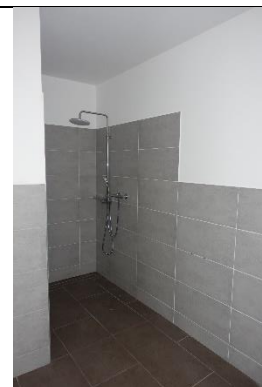
Sanitärausstattung: 1 Duschnische mit Armatur und Ablaufrinne; Anschlüsse für 1 Waschbecken sind vorhanden aber kein Waschbecken montiert; 1 Waschmaschinenanschluss;
