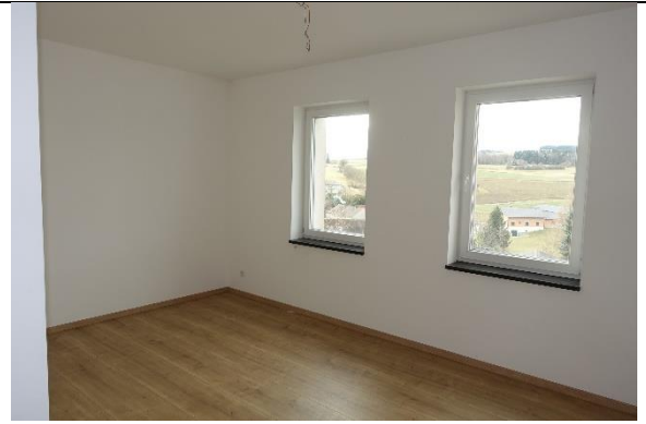
Wohnzimmer: Boden: Holzdielenboden; Wände und Decke: verputzt bzw. gespachtelt und gemalt;
