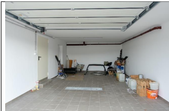
Garage: Boden: Fliesen; Wände und Decke: verputzt und gemalt;
