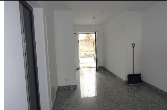
Stiegenhaus: Boden: Natursteinfliesen; Wände und Decke: verputzt bzw. gespachtelt und gemalt;
