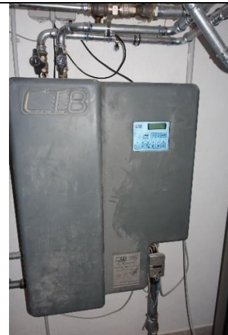
Fernwärmeübergabestation (30 kW),
