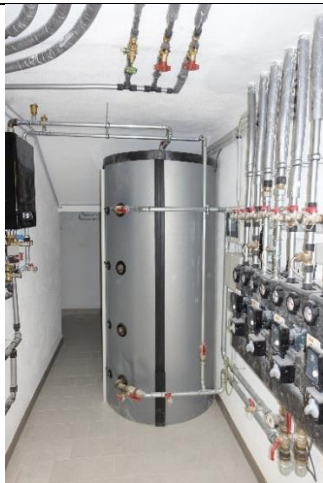
Abstellraum/Technik: Boden: Fliesen; Wände und Decke: verputzt und gemalt; 1 Heizungsverteileranlage mit 5 Heizkreisen, 1 Warmwasserspeicher (Fassungsvermögen 1.000 l);
