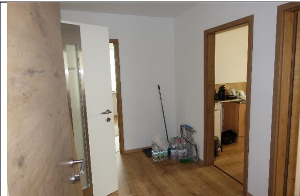
Vorraum: Boden: Holzdielenboden; Wände und Decke: verputzt bzw. gespachtelt und gemalt;
