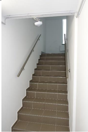
Treppe EG/KG: zweiläufige Massivtreppe mit Podest, jeweils mit Natursteinfliesen und Fliesenbelag; Metallhandlauf;
