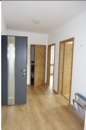
Vorraum: Boden: Holzdielenboden; Wände und Decke: verputzt bzw. gespachtelt und gemalt;
