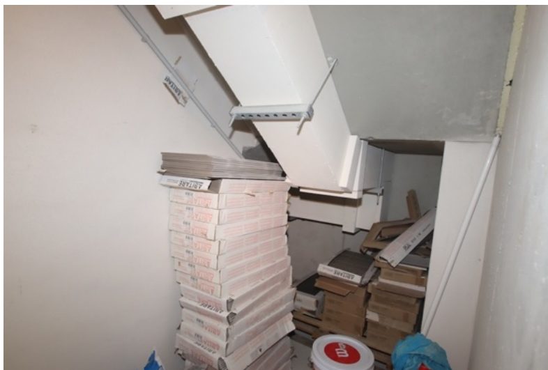
Abb. 19: Ansicht Lager S-2
