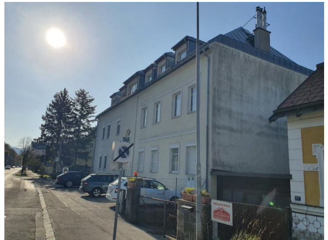
Abbildung: Blick auf die bewertungsgegenständliche Liegenschaft, Richtung Süden
